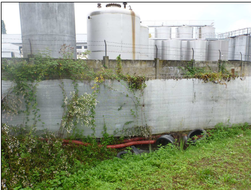
Figura 11. Tratto iniziale di fossato esterno all'area di intervento.
