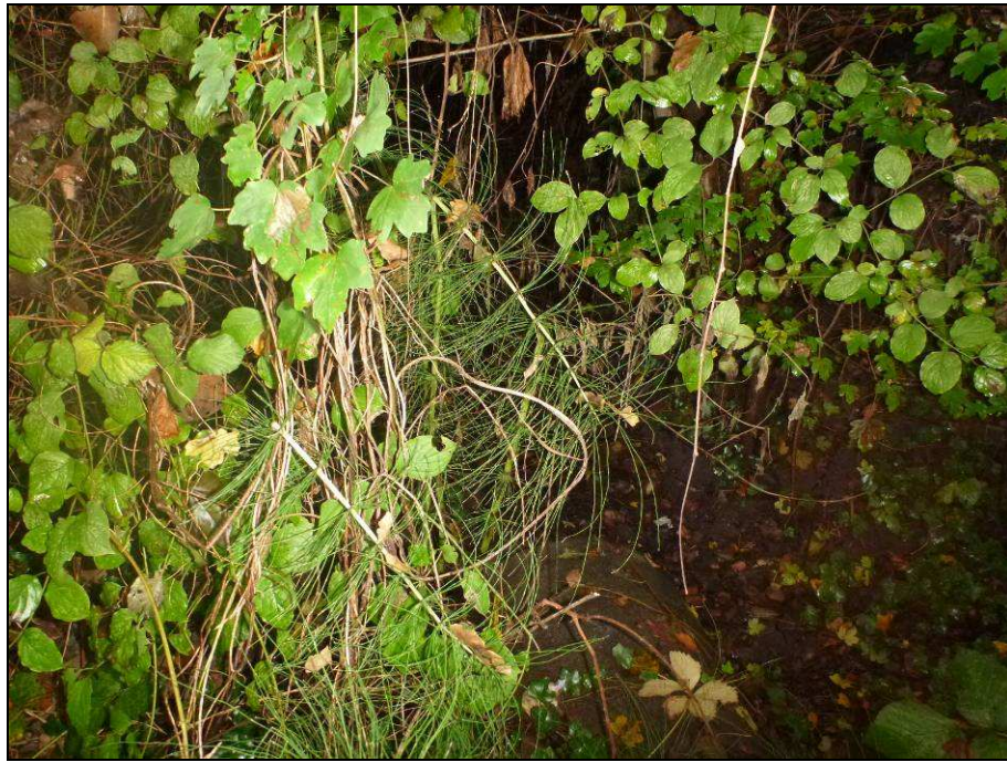
Figura 12. Fossato esistente cui assicurare la continuità idraulica. Tratto di valle a sud ovest e particolare della condotta di scarico cls.
