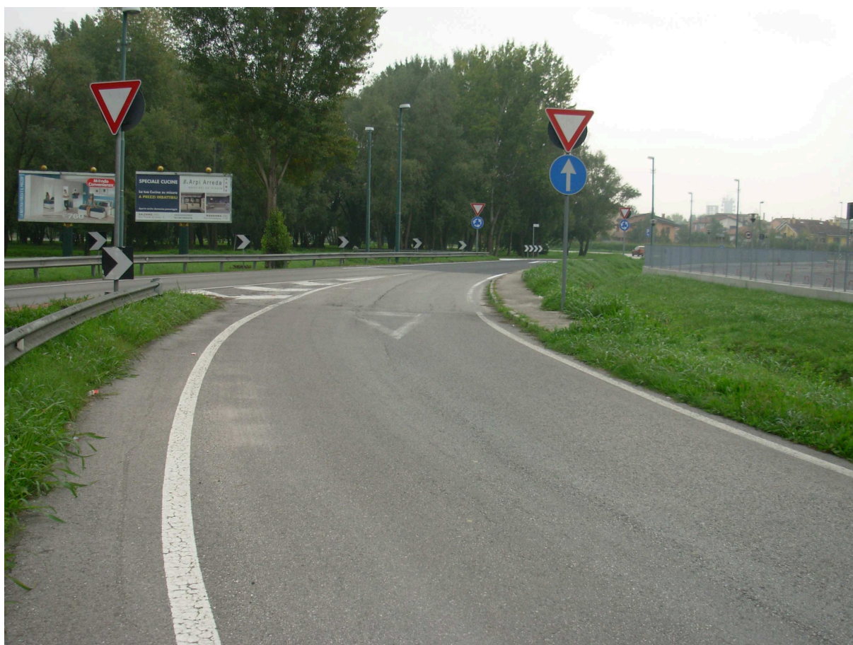
Foto n. 4 – Via Caravaggio (corsia P6)
