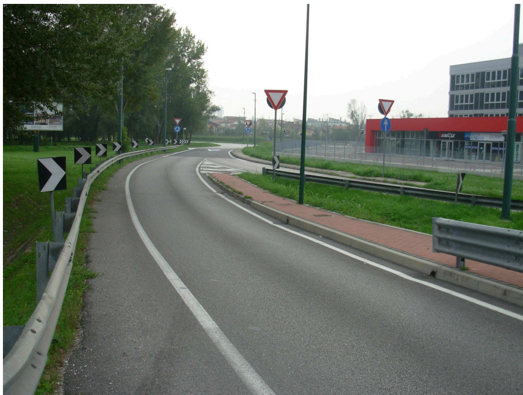
Foto n. 6 – Strada Regionale n. 245 (corsia P7)
