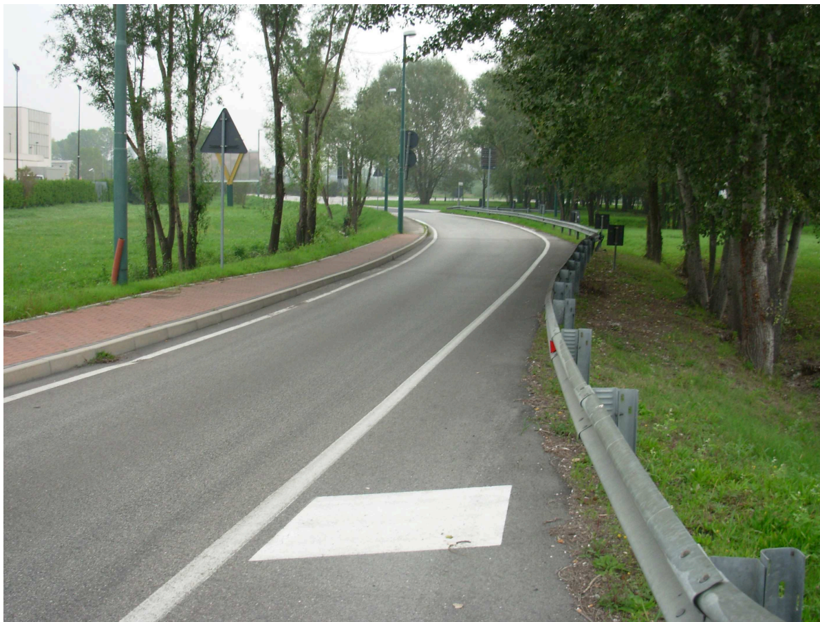
Foto n. 7 – Strada Regionale n. 245 (corsia P8)
