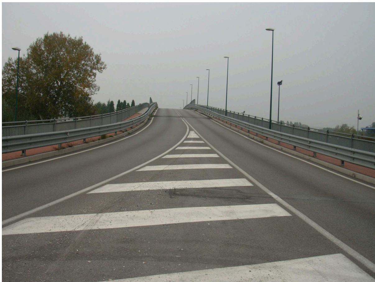
Foto n. 5 – Strada Regionale n. 245 (cavalcavia)
