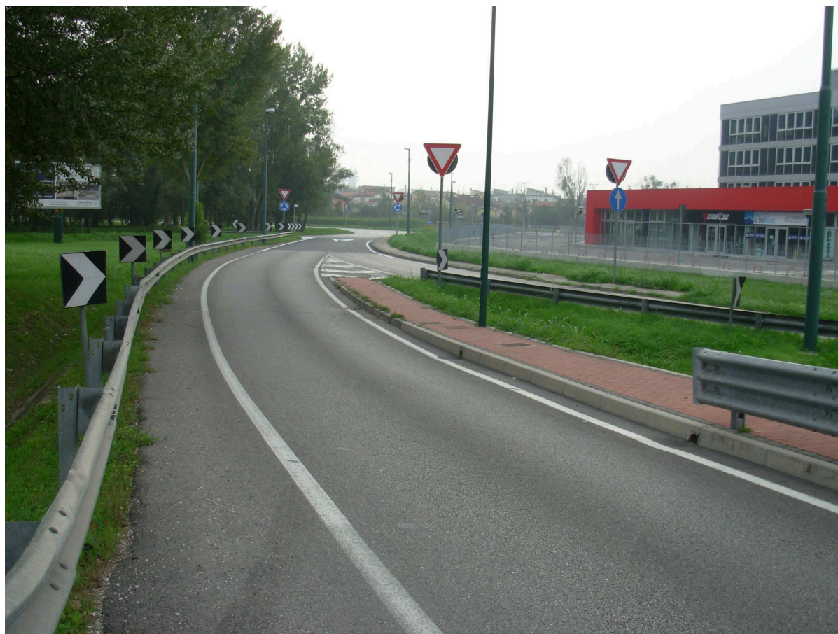
Foto n. 6 – Strada Regionale n. 245 (corsia P7)
