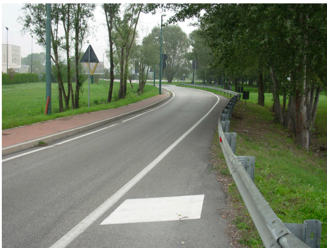
Foto n. 7 – Strada Regionale n. 245 (corsia P8)
