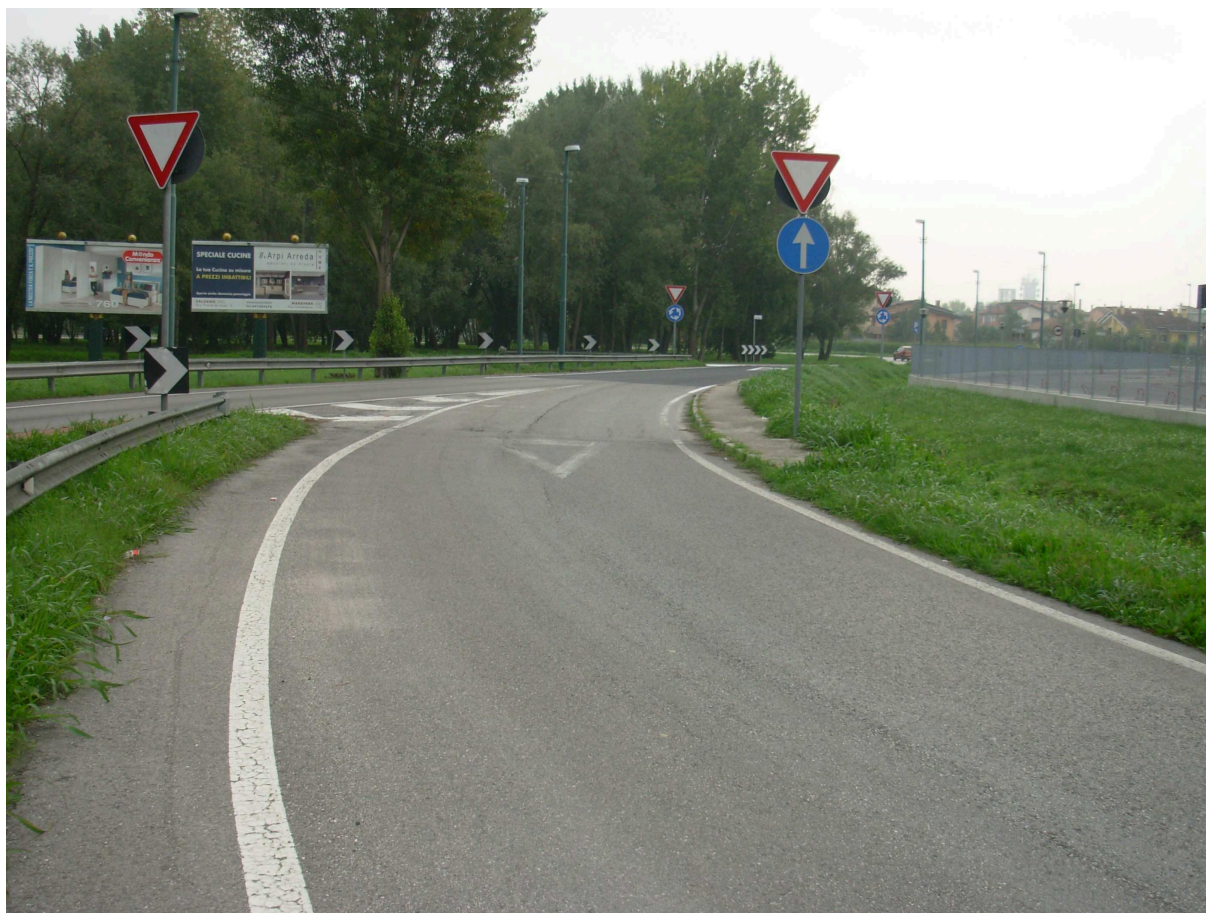
Foto n. 4 – Via Caravaggio (corsia P6)
