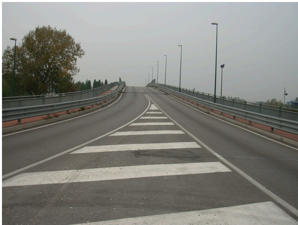
Foto n. 5 – Strada Regionale n. 245 (cavalcavia)
