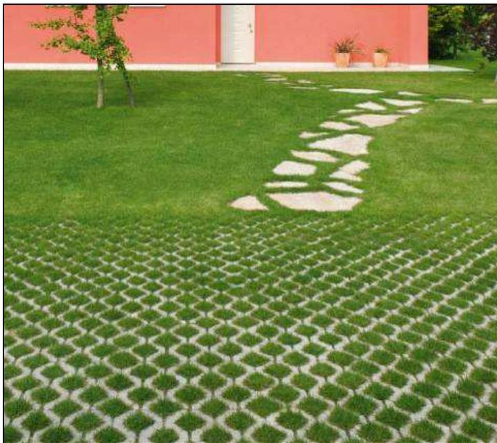
Figura 37: pavimentazione drenante in grigliato erboso
