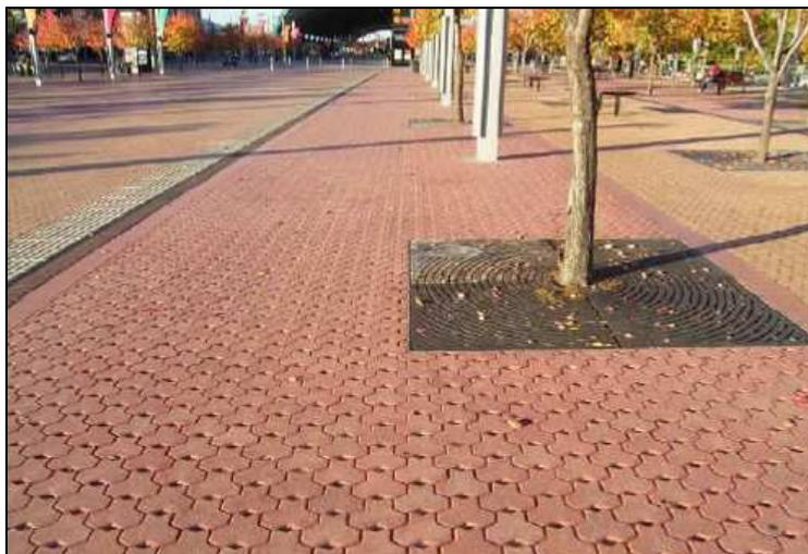
Figura 38: pavimento in betonelle drenanti
