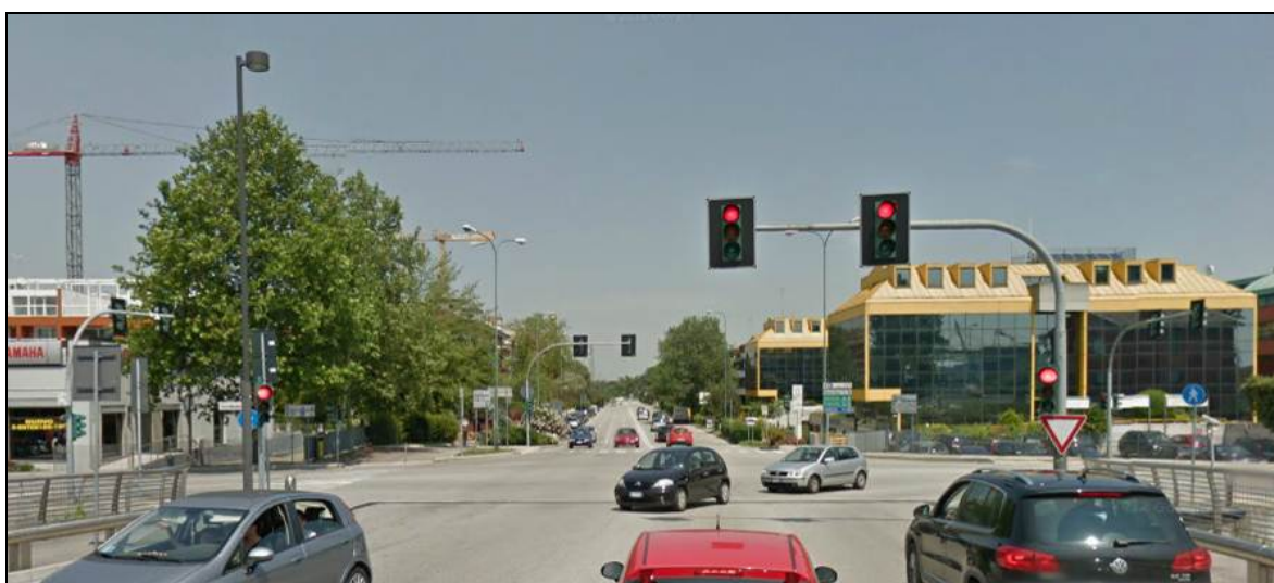
Figura 18 – intersezione via Sansovino, via Forte Marghera, viale Ancona – da viale Ancona
