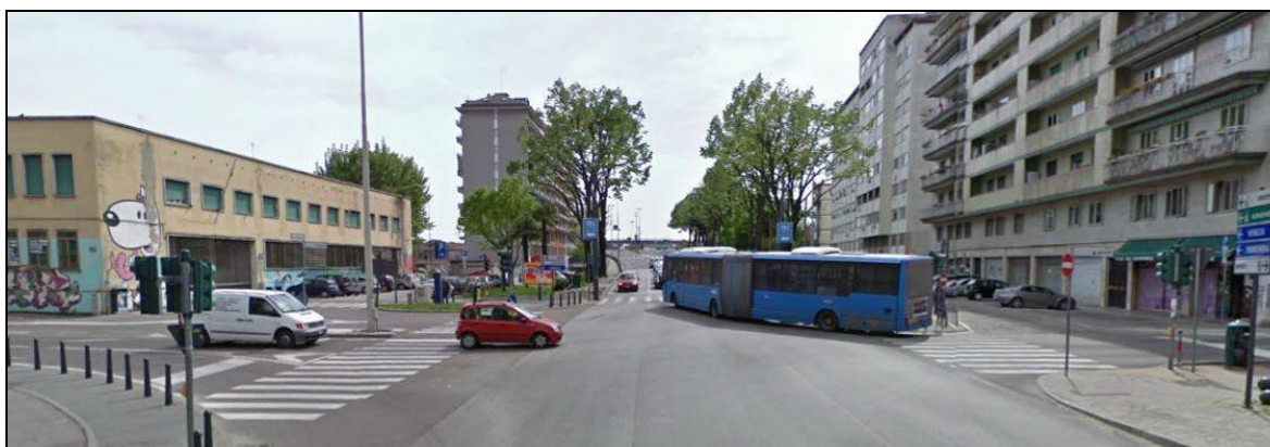
Figura 10 – intersezione Corso del Popolo, via Torino, via Gozzi – vista da nord
