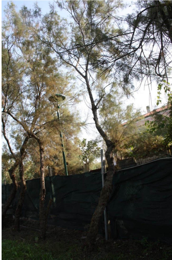
Figura 2-11: Tamerici posti lungo la recinzione Sud dell' area: si possono notare i fusti filati
