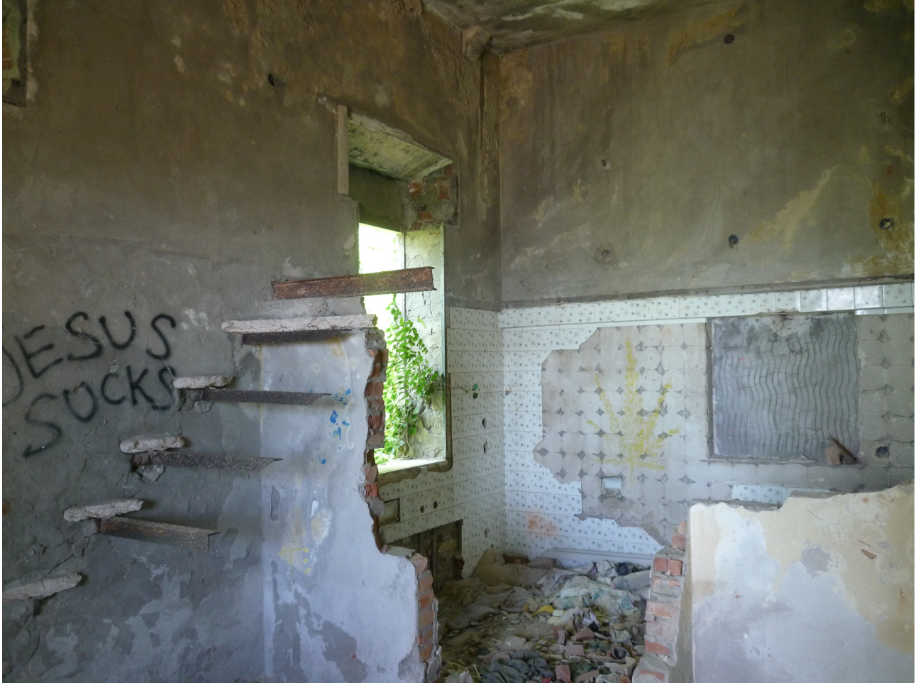
4. Ex stazione radio (edificio n.3): interno
