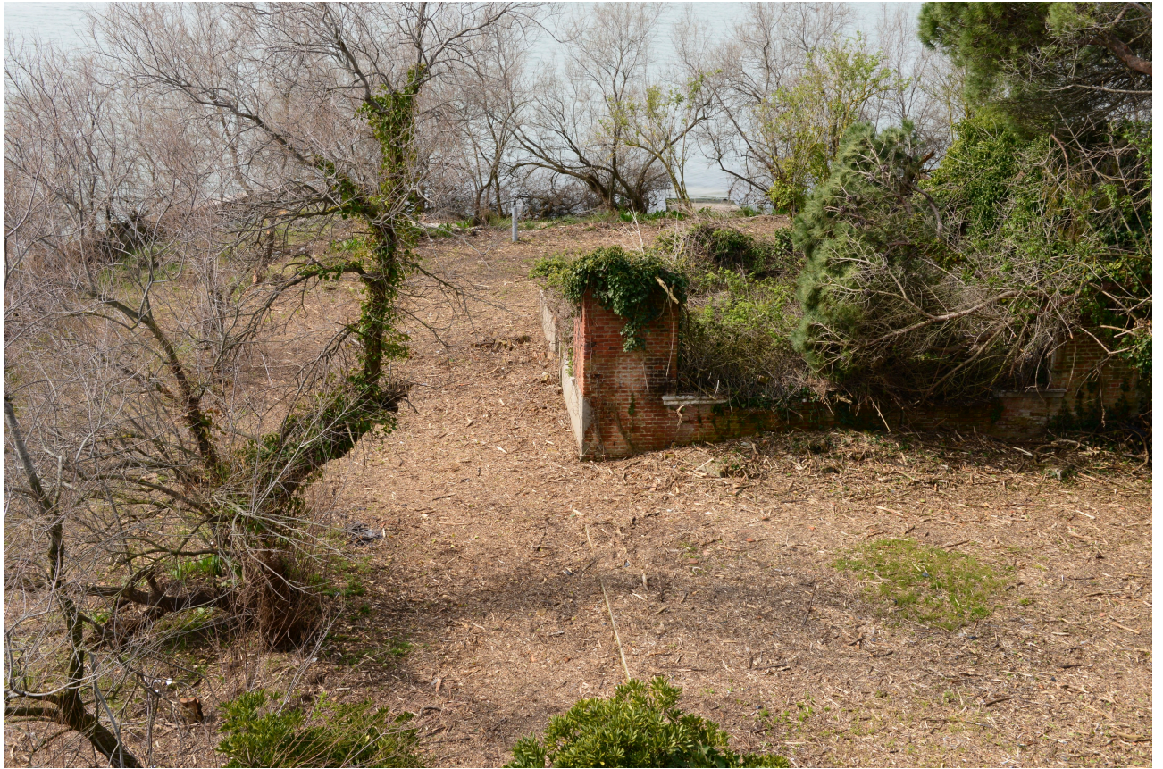
6. Ex alloggio militari (edificio n. 2)
