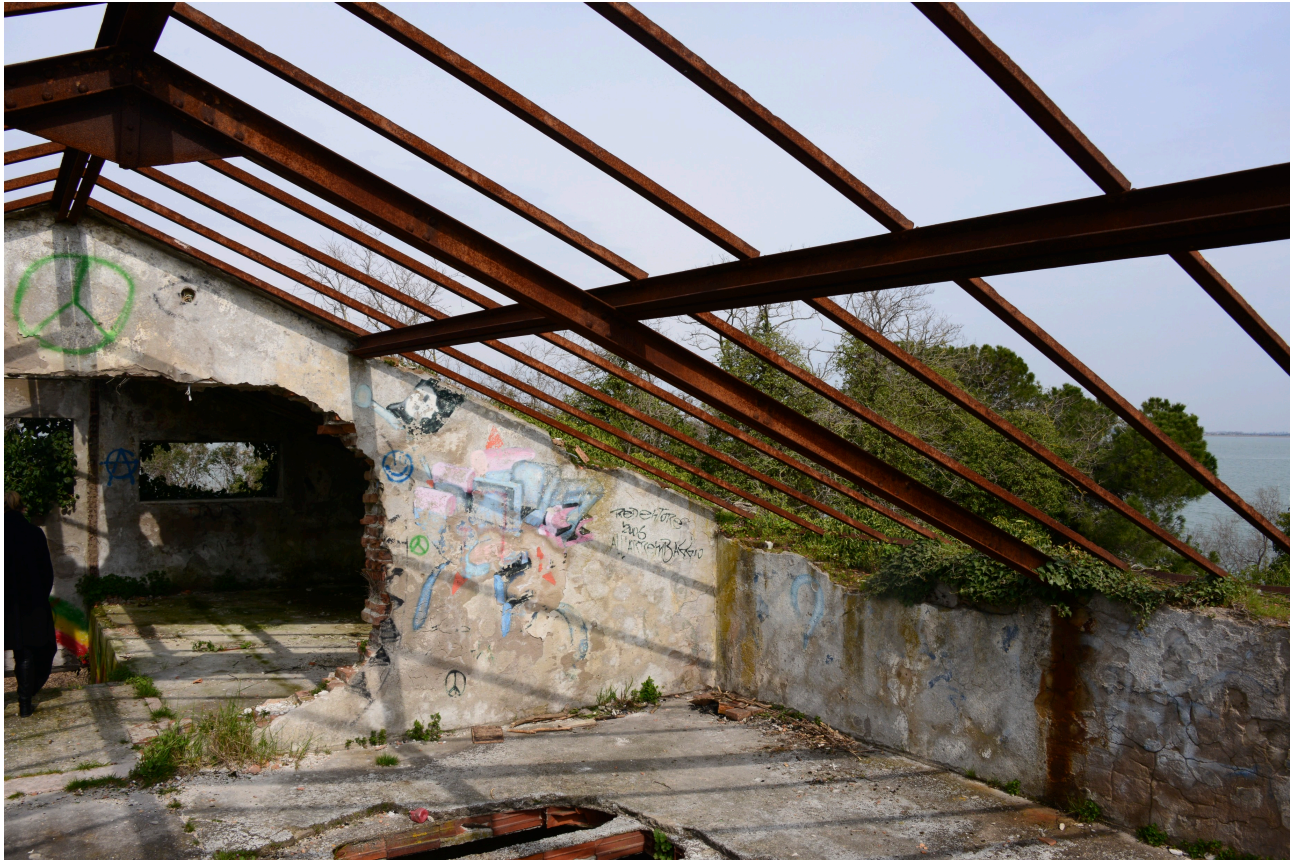
5. Ex stazione radio (edificio n.3) copertura
