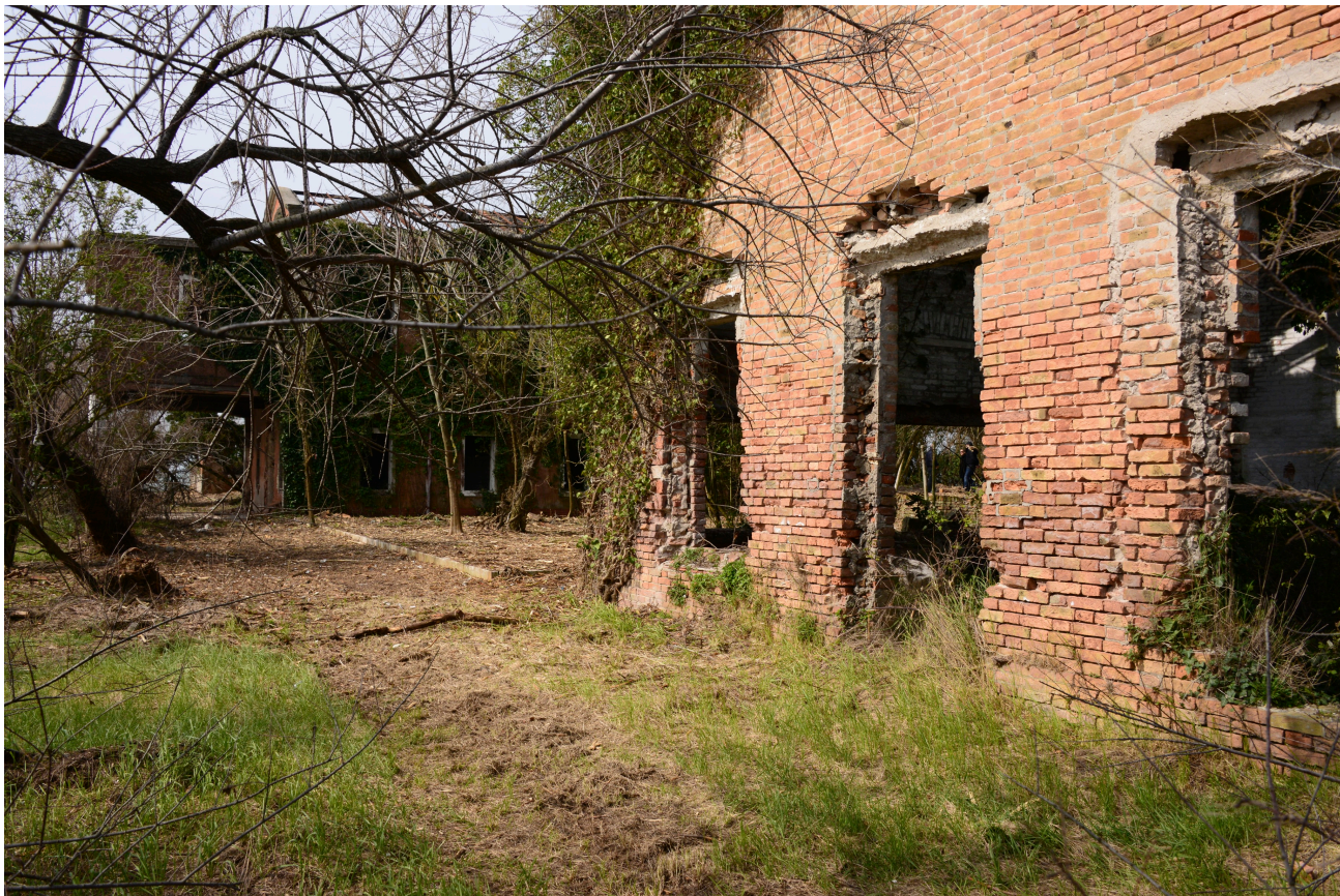
7. Ex alloggio militari (edificio n. 4)
