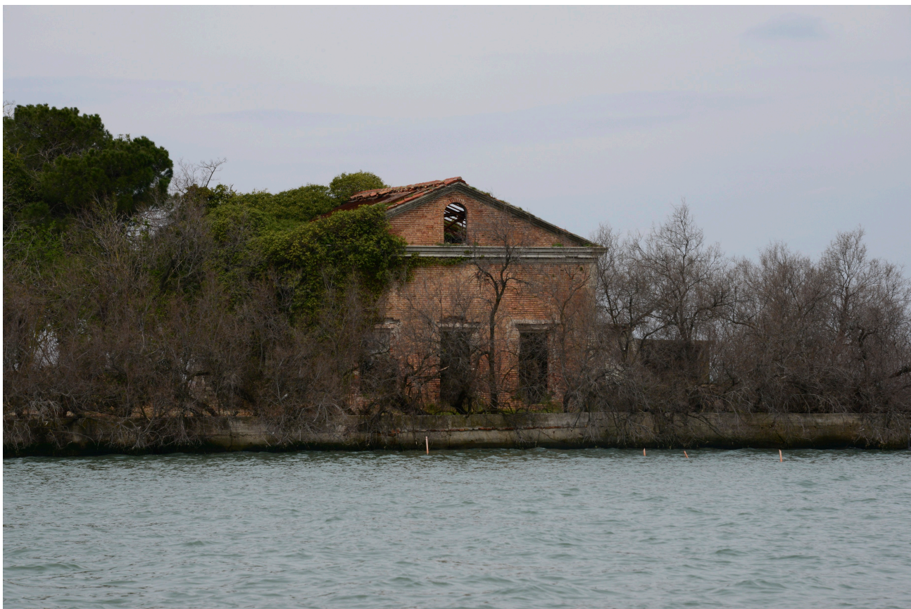
8. Ex alloggio militari (edificio n. 4)
