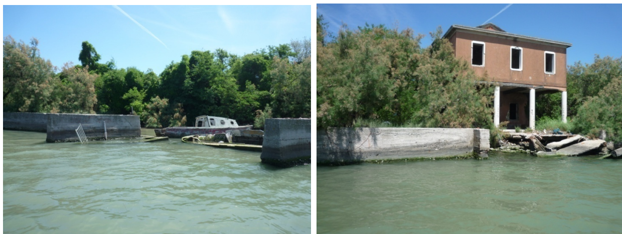
La darsena (a sinistra) e l'edificio 2.1 (a destra) – stato attuale
