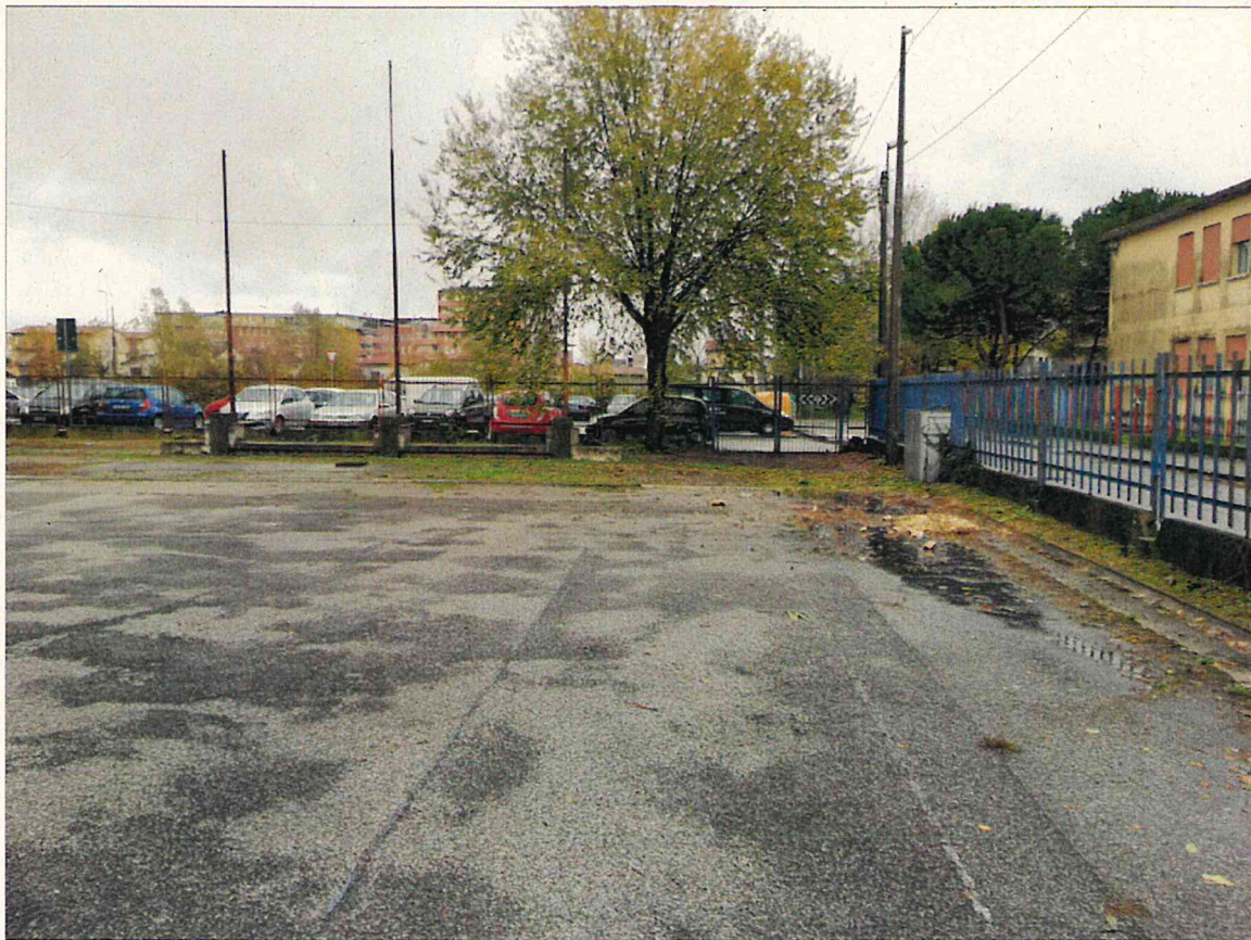
FOTO n. 4_ Piazzale interno ove sarà realizzato l'ampliamento
