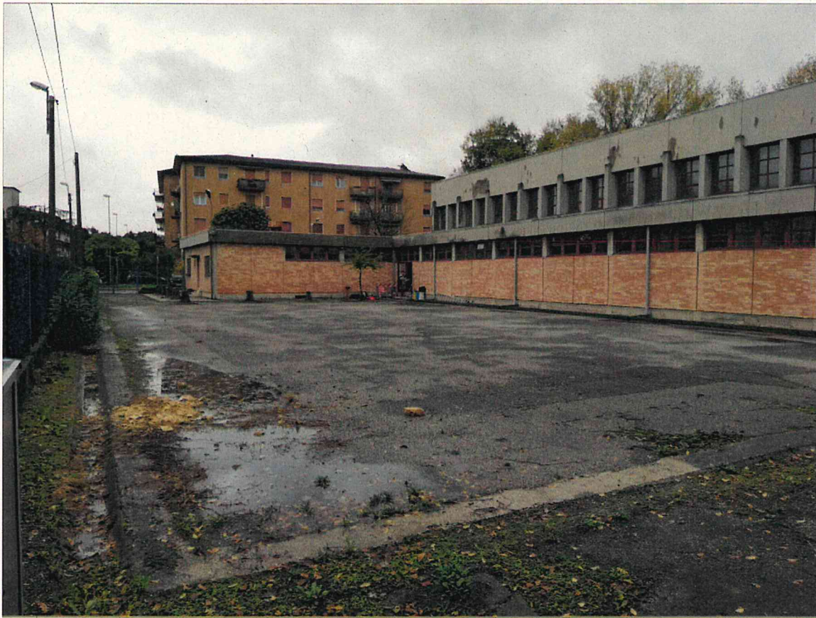
FOTO n.3_ Piazzale interno ove sarà realizzato l'ampliamento
