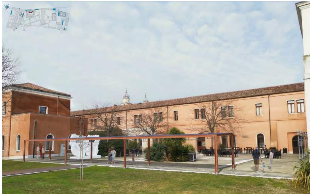
Intervento 2 - Pensilina fotovoltaica
