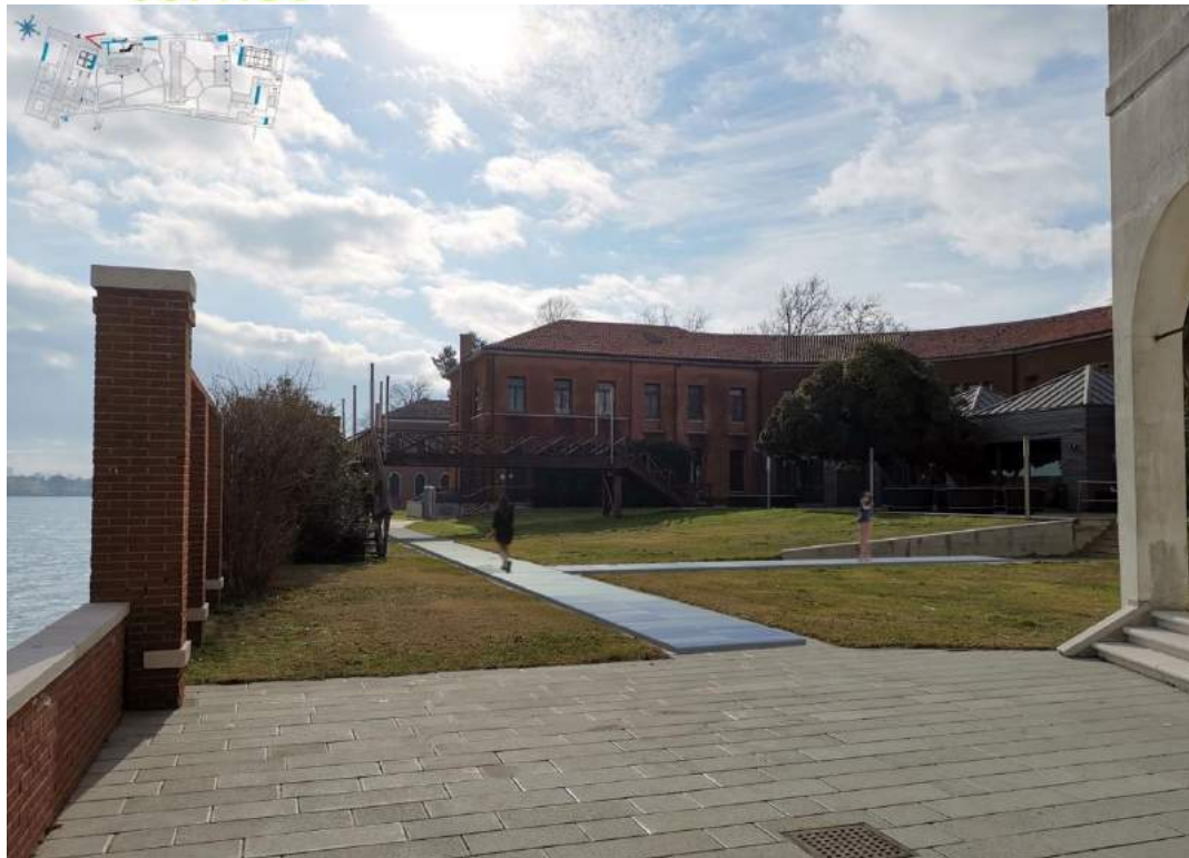
Intervento 3 – Pavimento flottante fotovoltaico
