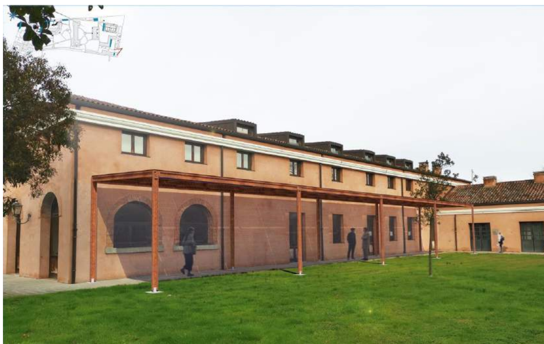
Intervento 7 - Pensilina fotovoltaica
