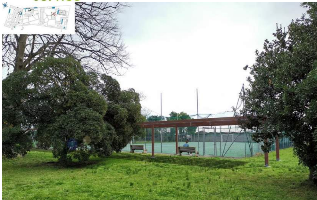
Intervento 6 - Pensilina fotovoltaica
