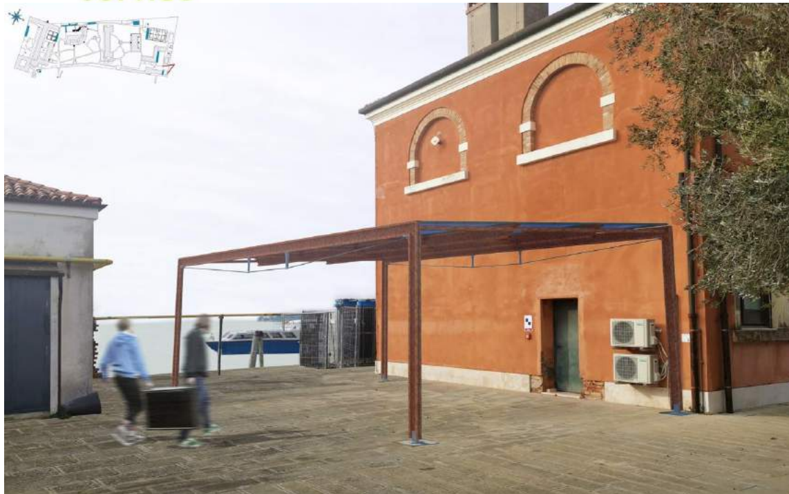
Intervento 9 - Pensilina fotovoltaica
