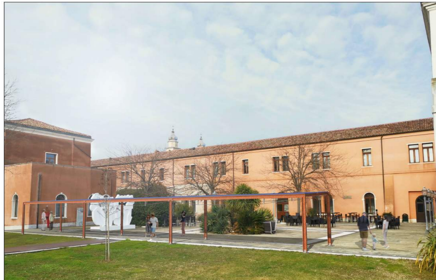
COPERTURA AREA RISTORO
