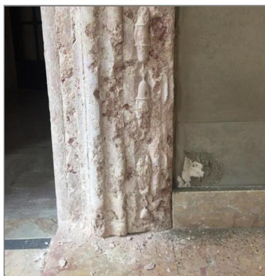
*Sala della Borsa: discontinuità pannello in cemento rinforzato / intonaco e pedritti del portale in marmo (degrado 2018)*
