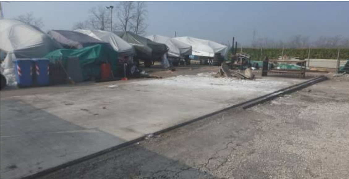
Vista 2 – area edifici demoliti
