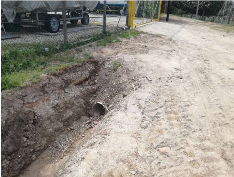
Figura 4.2 – La condotta terminale Ø300 mm esistente
