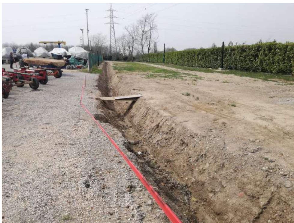
Figura 4.1 – Il fosso esistente visto da Nord verso Sud
