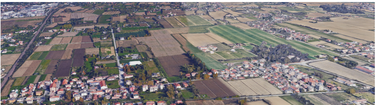
Vista aerofotogrammetrica del compendio oggetto d'intervento ad Asseggiano. (Fonte: Google Earth)
