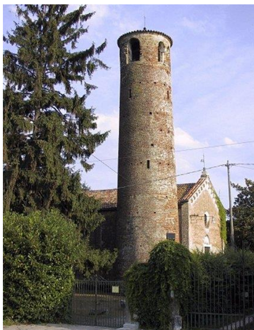
Figura 5-136: La Chiesa SS. Antonio e S. Elena e la Torre di Tessera
