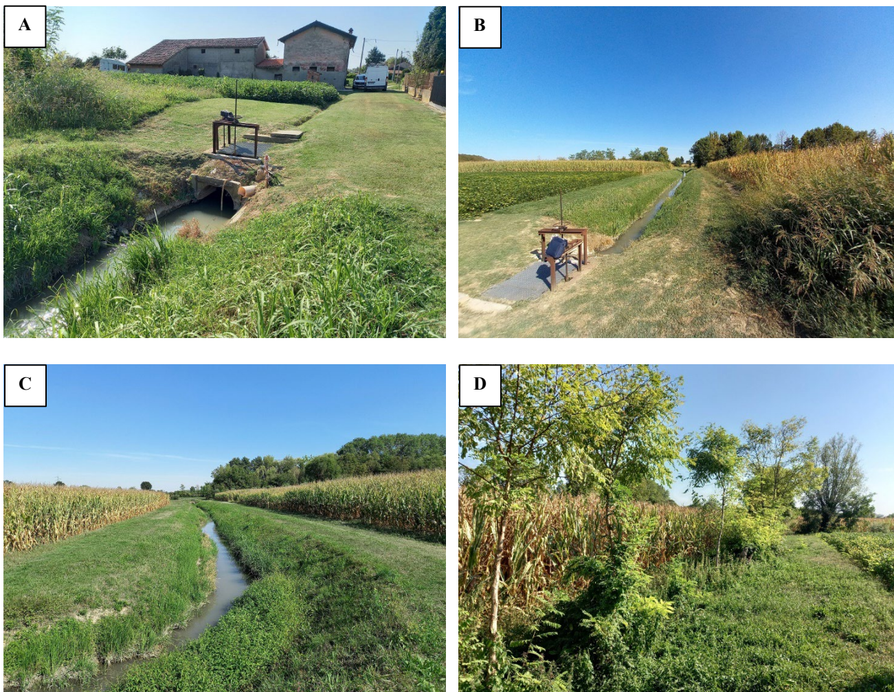
Figura 33: Documentazione fotografica dell'area d'intervento. (A) Manufatto di immissione all'origine del Collettore Boscariola Monte. (B) Vista verso est del Collettore Boscariola Monte. (C) Proseguimento verso est del Collettore Boscariola Monte. (D) Vista verso monte dell'affossatura da risezionare.
