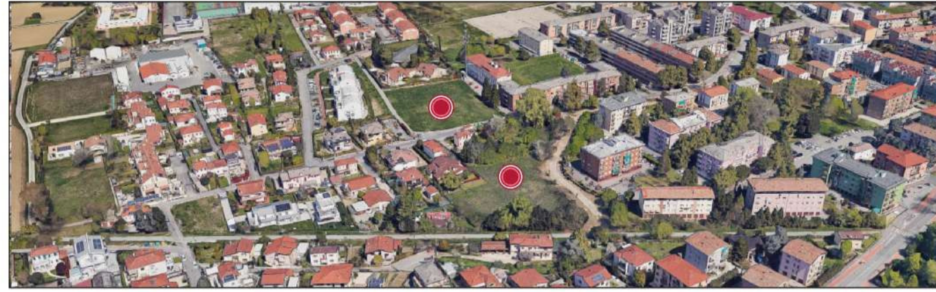
Vista aerea dell'ambito d'intervento in via Etruria (Gazzera).
