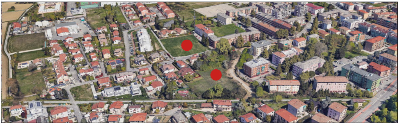
Vista aerea dell'ambito d'intervento in via Etruria (Gazzera).
