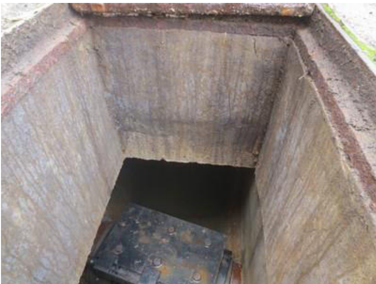
Figura 5: Alto= sud: by-pass tubo acque nere/miste.
