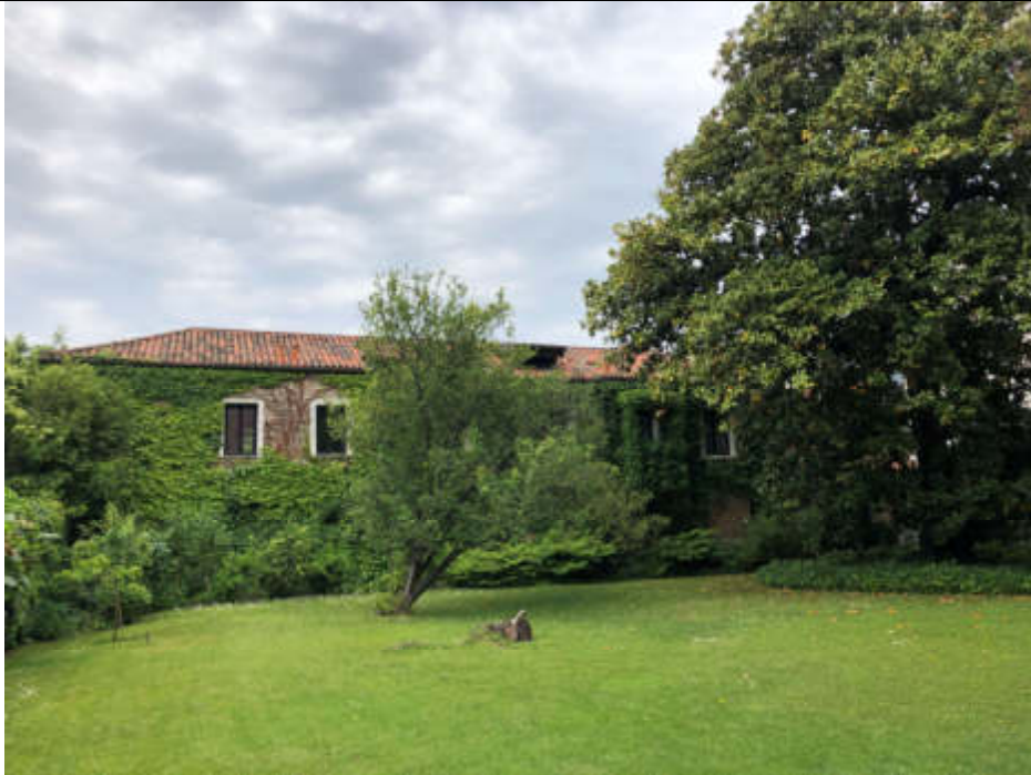
3 Vista giardino verso facciata Villa "F"
