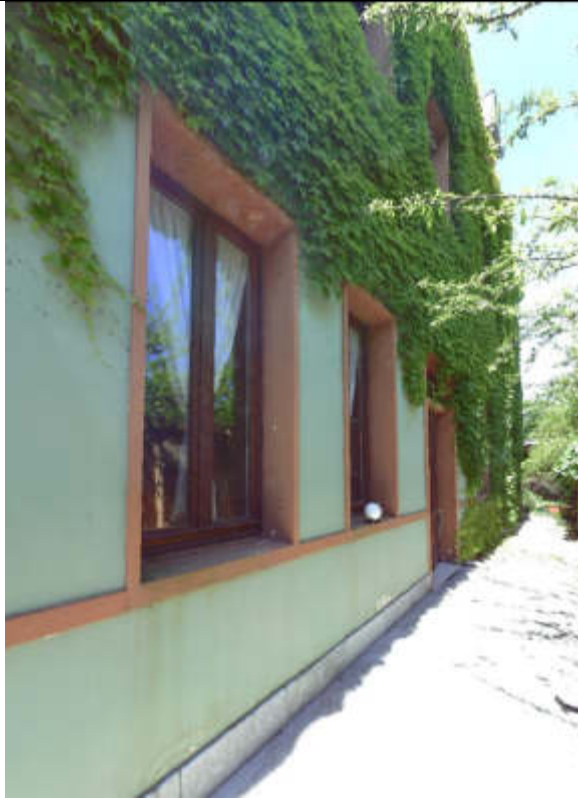
3 Prospetto Est, fori finestra e porta oggetto di tamponamento
