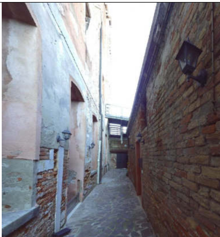
2 Prospetto Ovest, vista da calle interna
