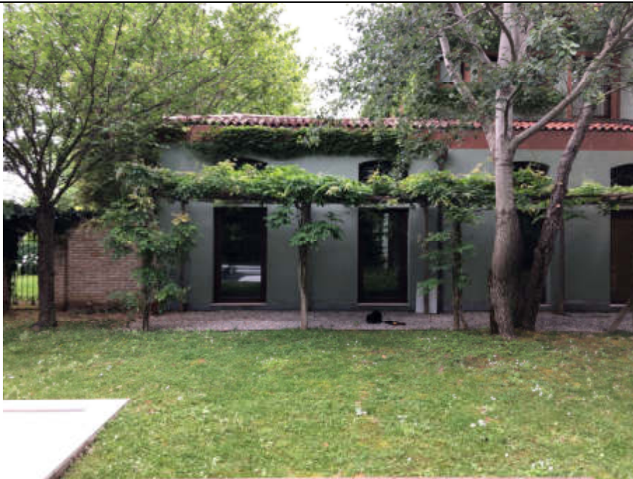
6 Prospetto Ovest: infissi oggetto di sostituzione
