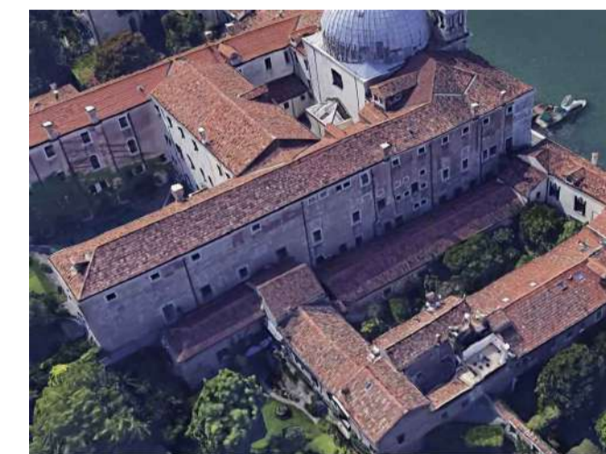
15_STATO DI FATTO
