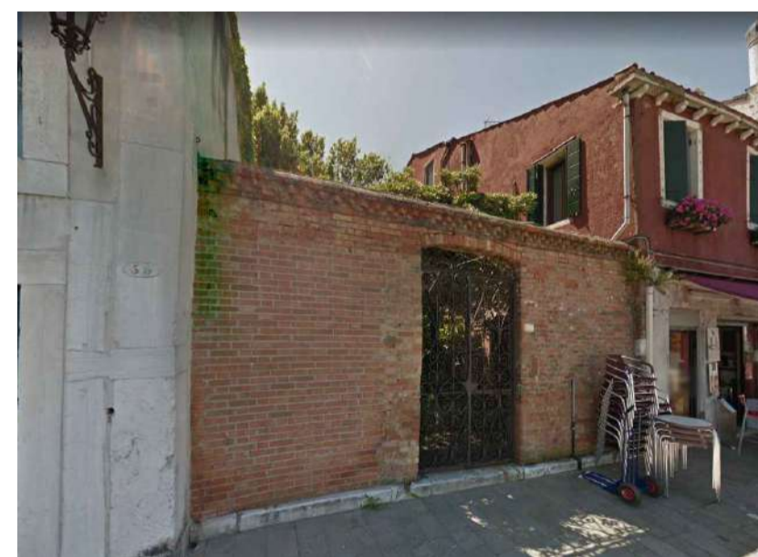
1_STATO DI FATTO
