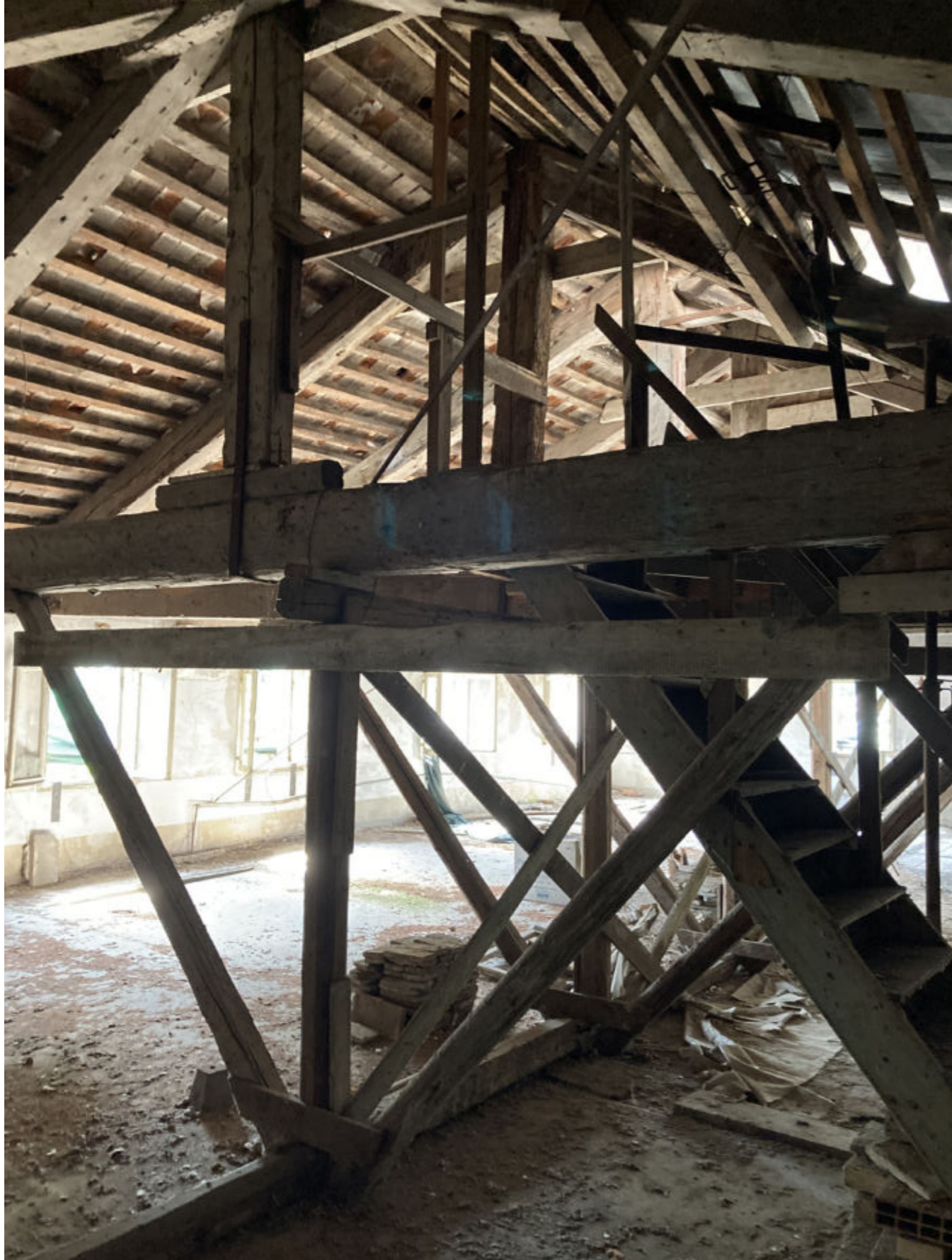
COMPLESSO CASA SUORE - FIGURA 10 - INTERNI - SOTTOTETTO
