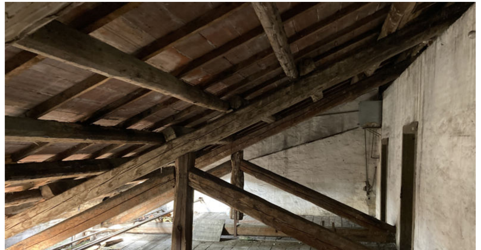
COMPLESSO CASA SUORE - FIGURA 12 - INTERNI - SOTTOTETTO
