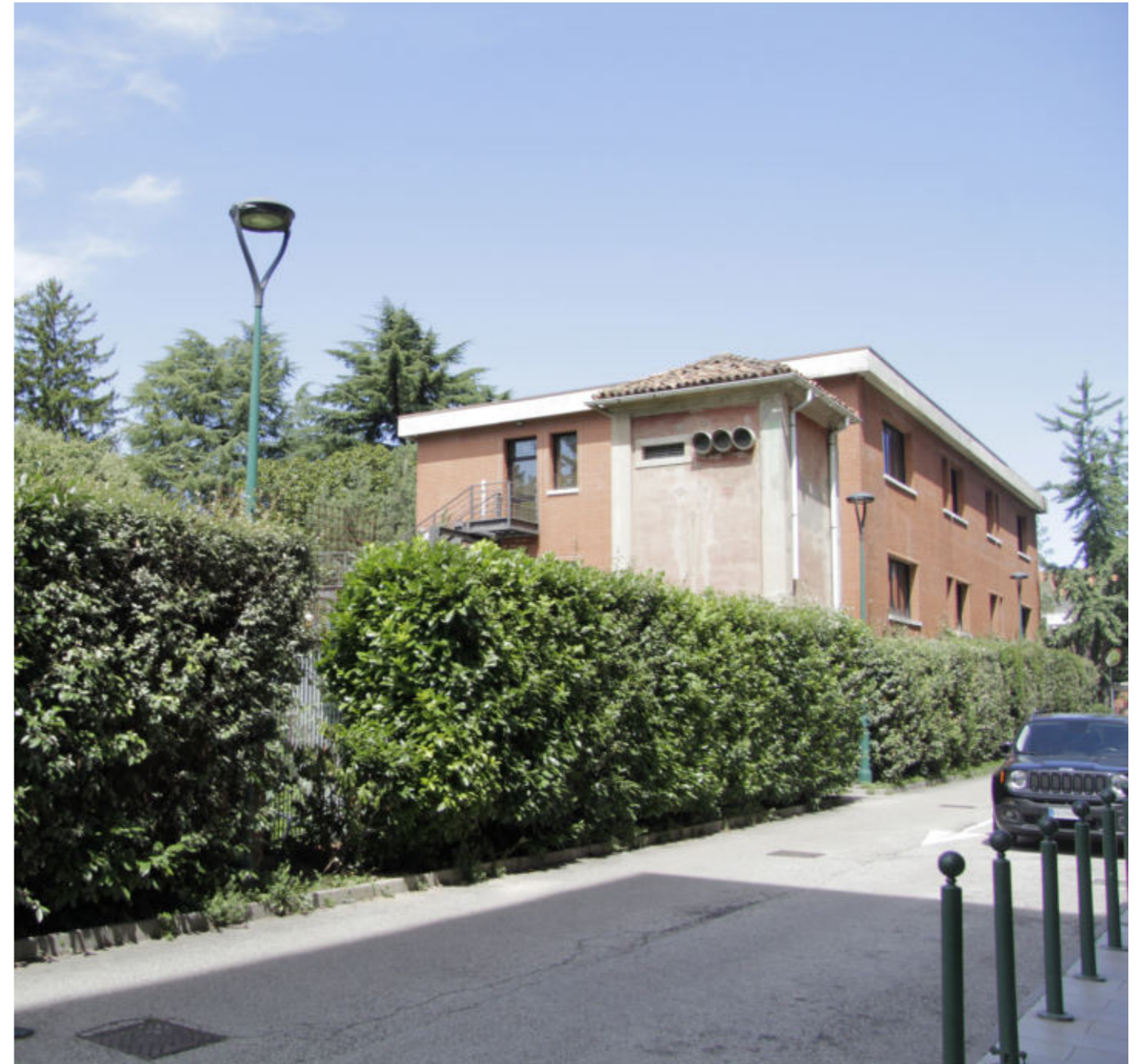
CENTRO PRELIEVI - FIGURA 3 - PROSPETTI SUD E EST DA VIA ANTONIO DA MESTRE
