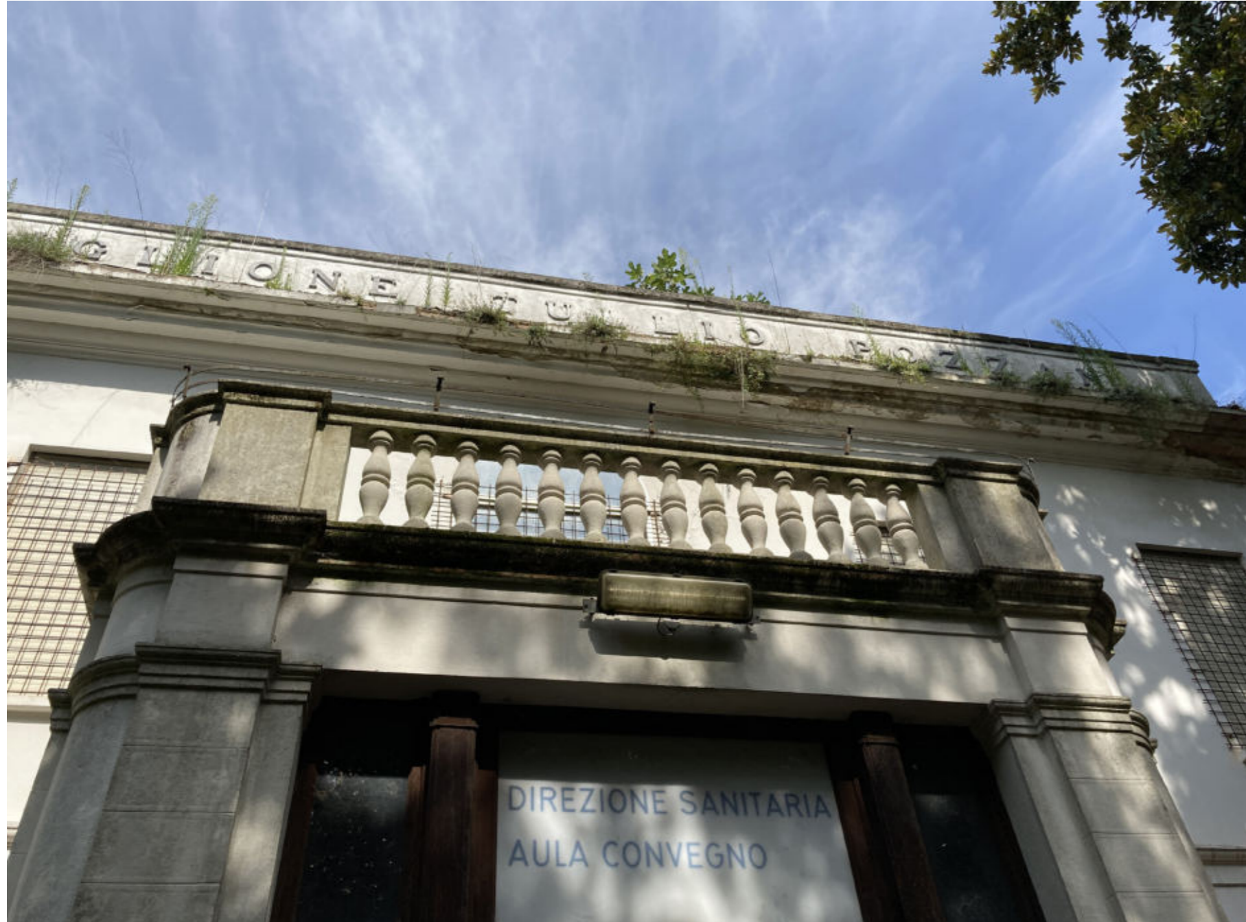
PADIGLIONE POZZAN - FIGURA 4 - DETTAGLIO DELL'INGRESSO
