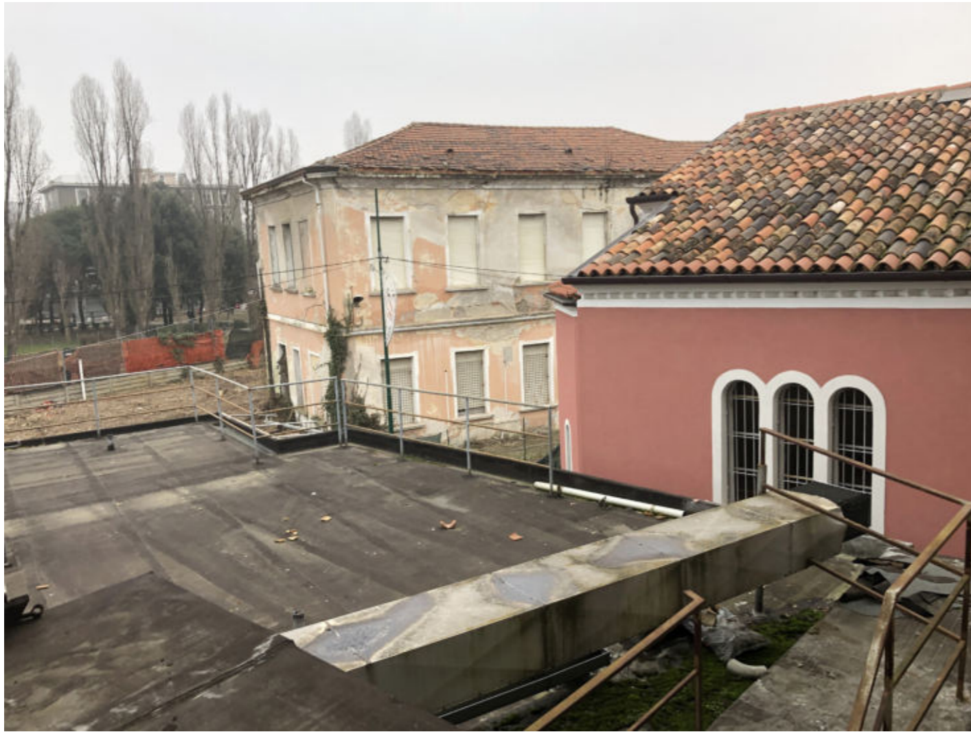
COMPLESSO CASA SUORE - FIGURA 5 - COPERTURA SPOGLIATOI
