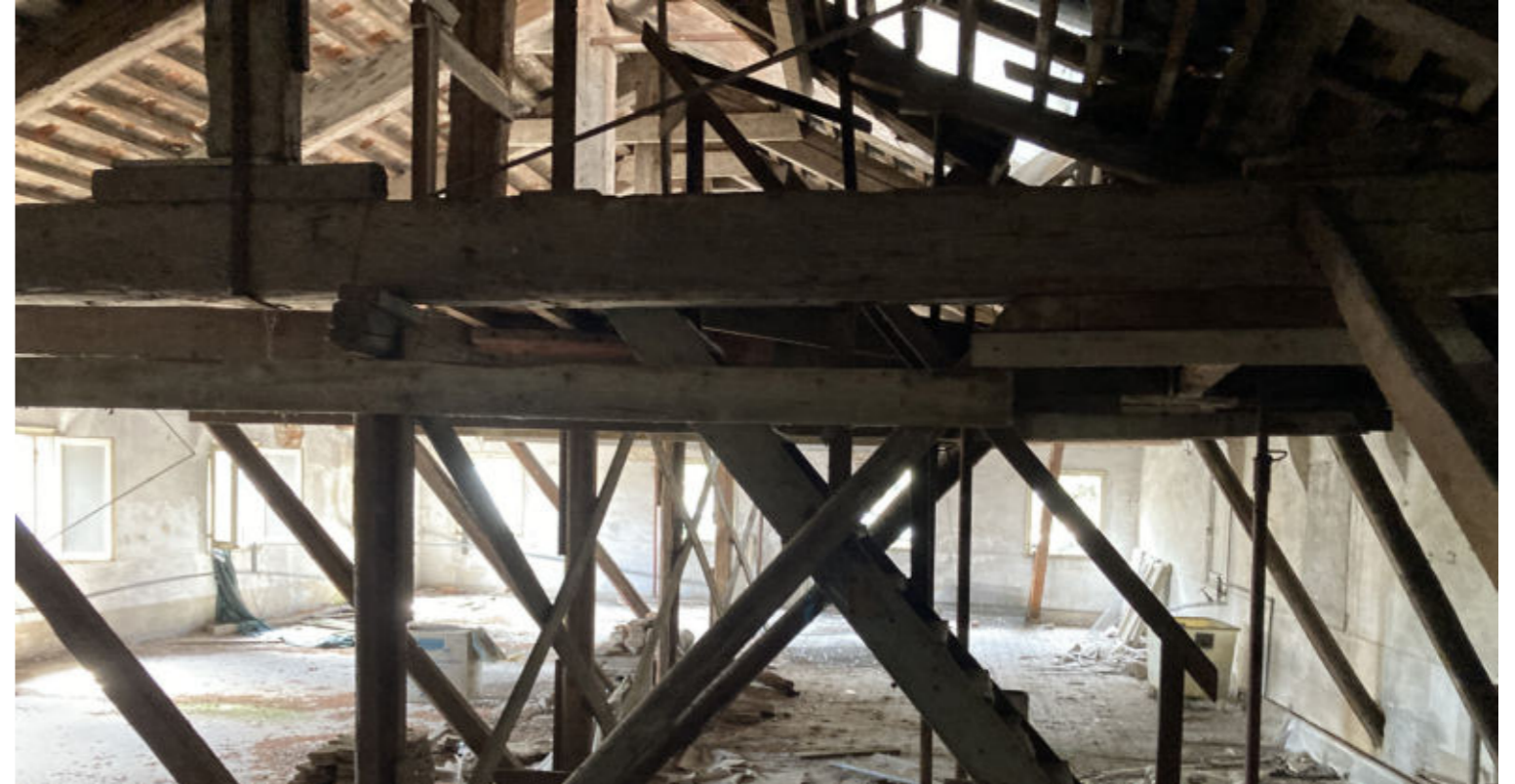
COMPLESSO CASA SUORE - FIGURA 11 - INTERNI - SOTTOTETTO
