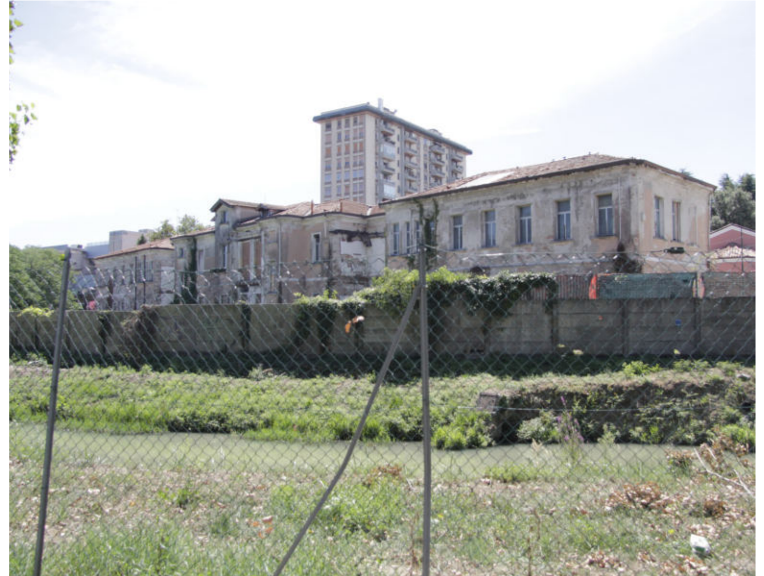
PADIGLIONE DE ZOTTIS - FIGURA 3 - PROSPETTO NORD DA PARCO DELLO SCOUTISMO
