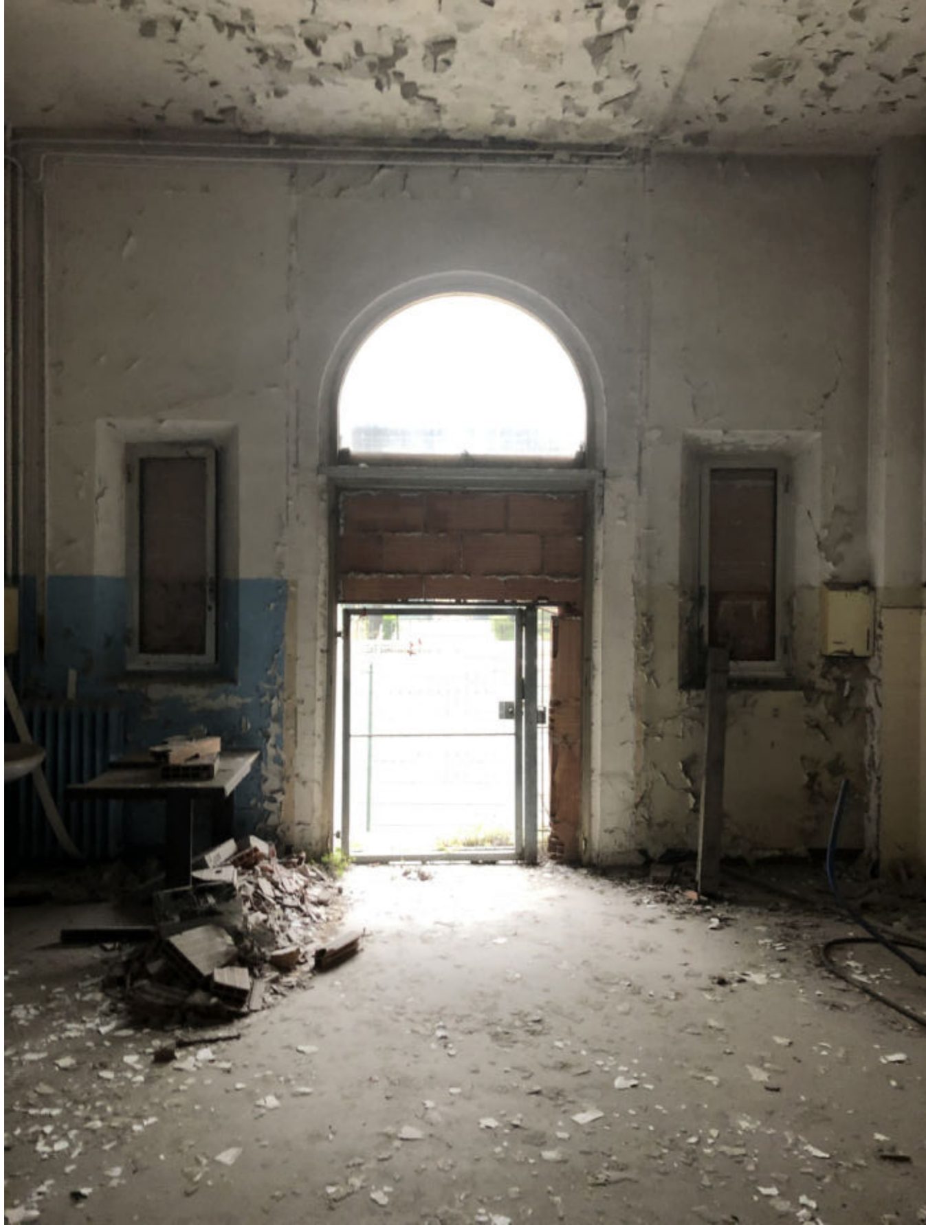
COMPLESSO CASA SUORE - FIGURA 8 - INTERNI
