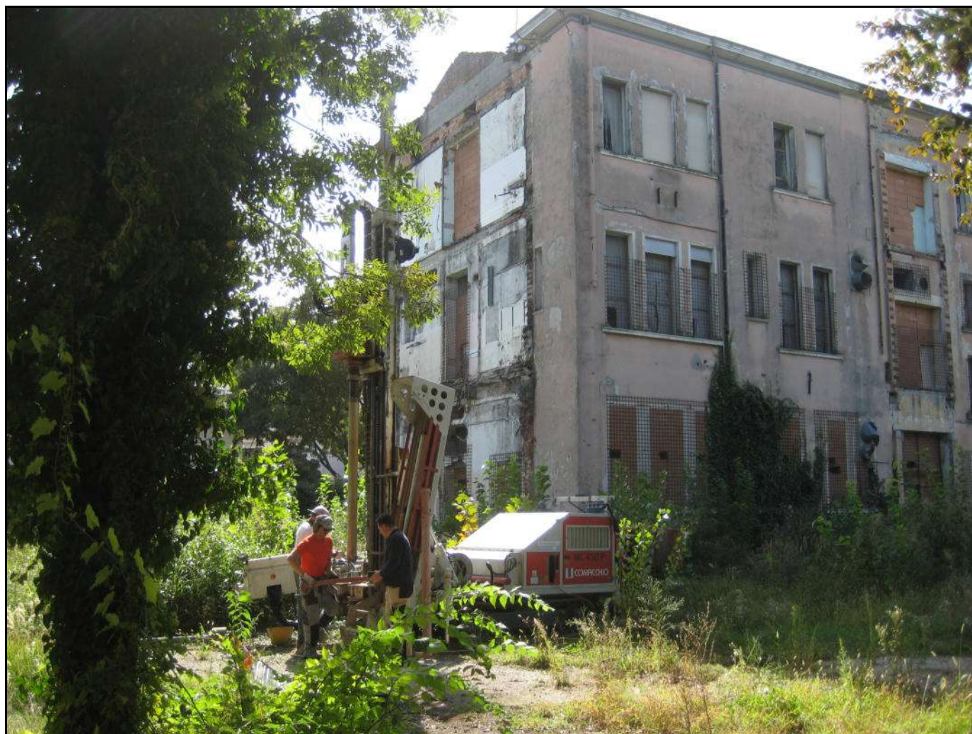
Posizionamento Sondaggio Ambientale C15
