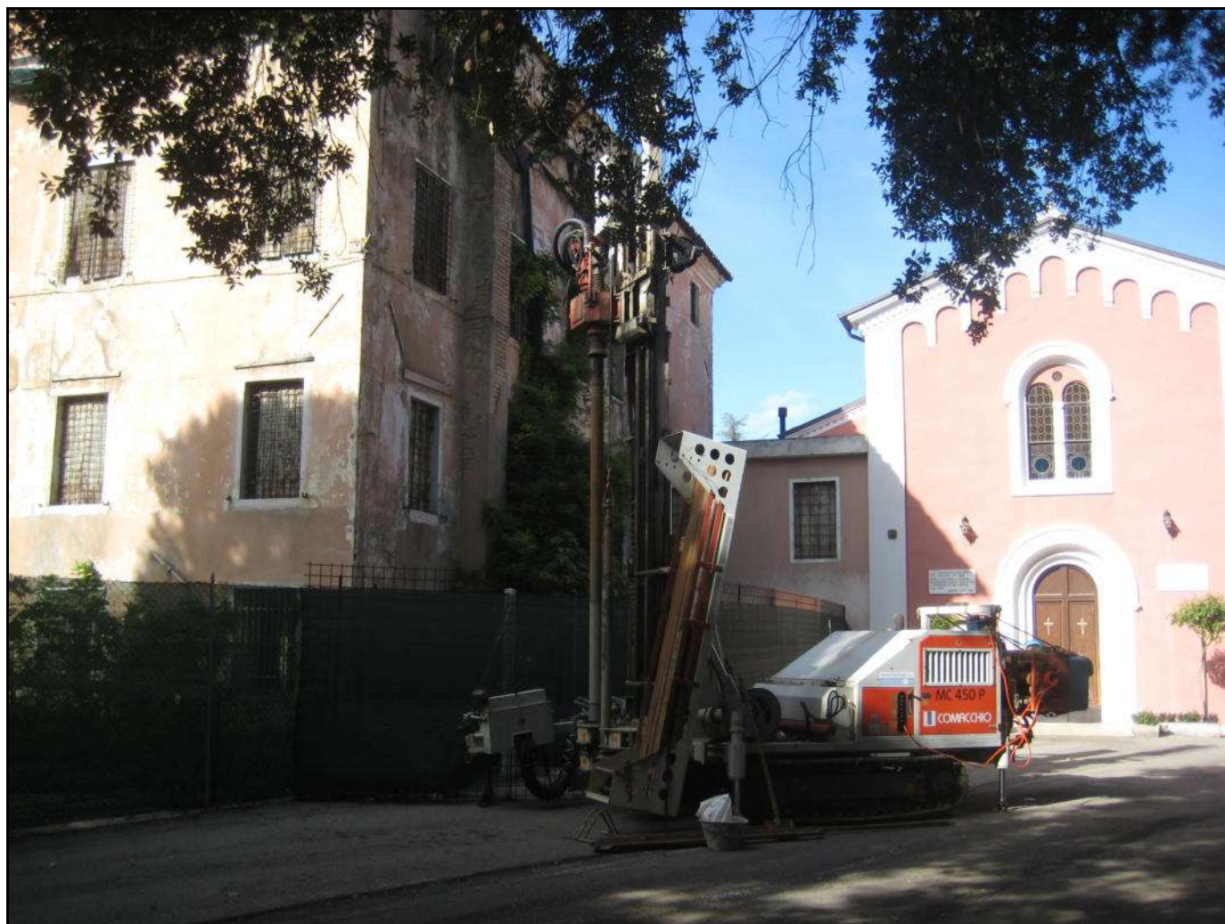
Posizionamento Sondaggio Ambientale C12
