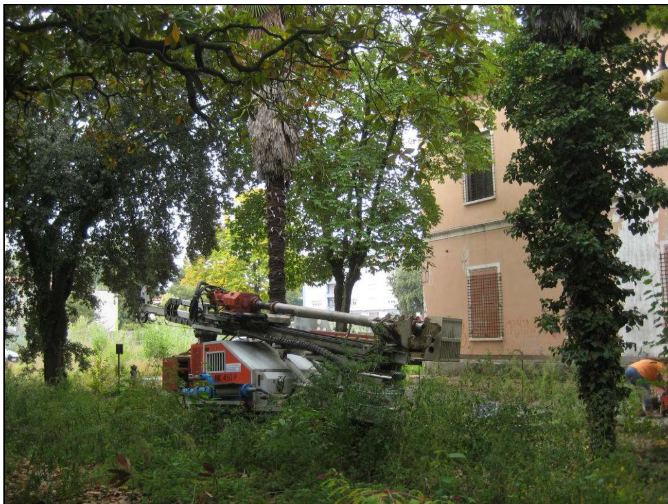
Posizionamento Sondaggio Ambientale C14
