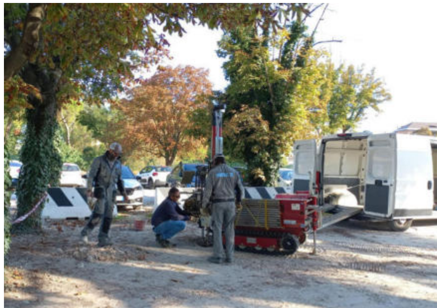
Foto 10: Esecuzione della prova CPTU11
