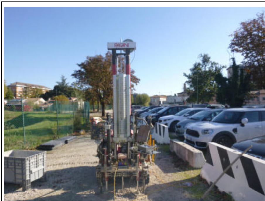
Foto 8: Esecuzione della prova CPTU9
