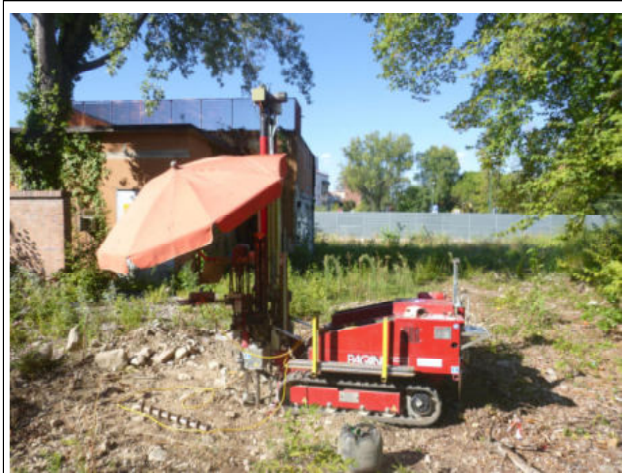
Foto 7: Esecuzione della prova CPTU8
