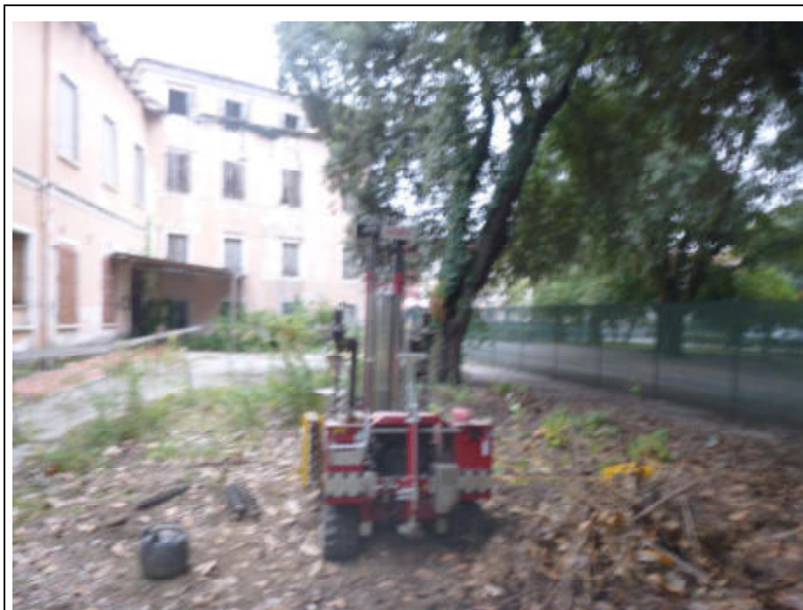
Foto 12: Esecuzione della prova CPTU13
