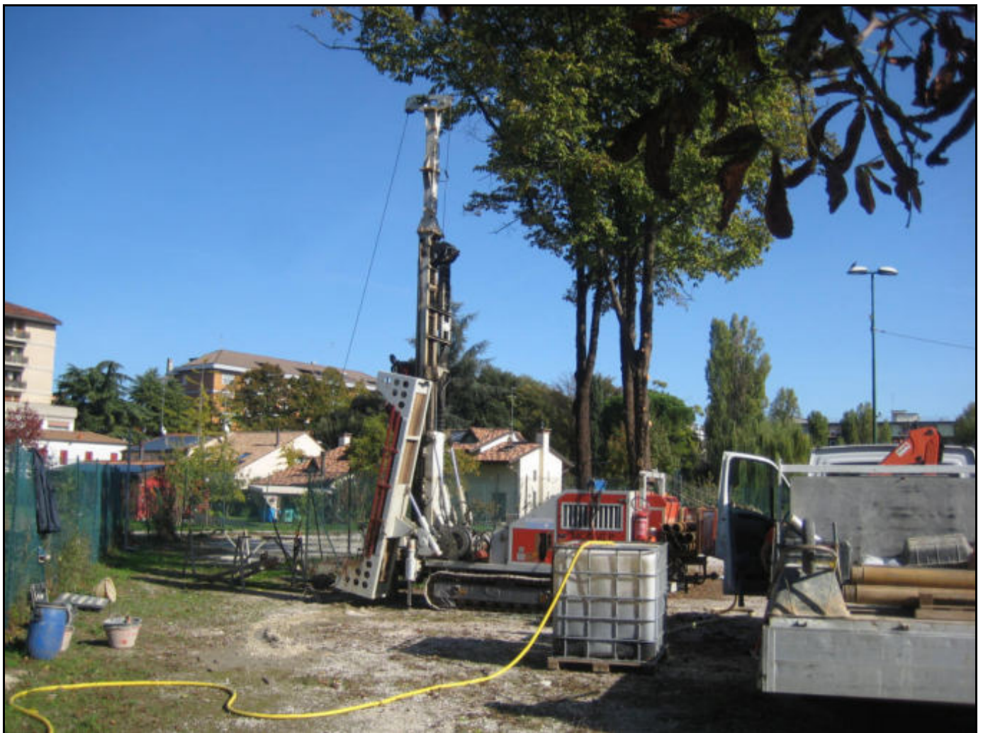
Posizionamento Sondaggio Geognostico S2
