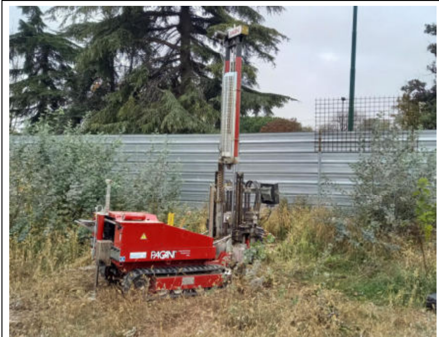
Foto 13: Esecuzione della prova SPTU1
