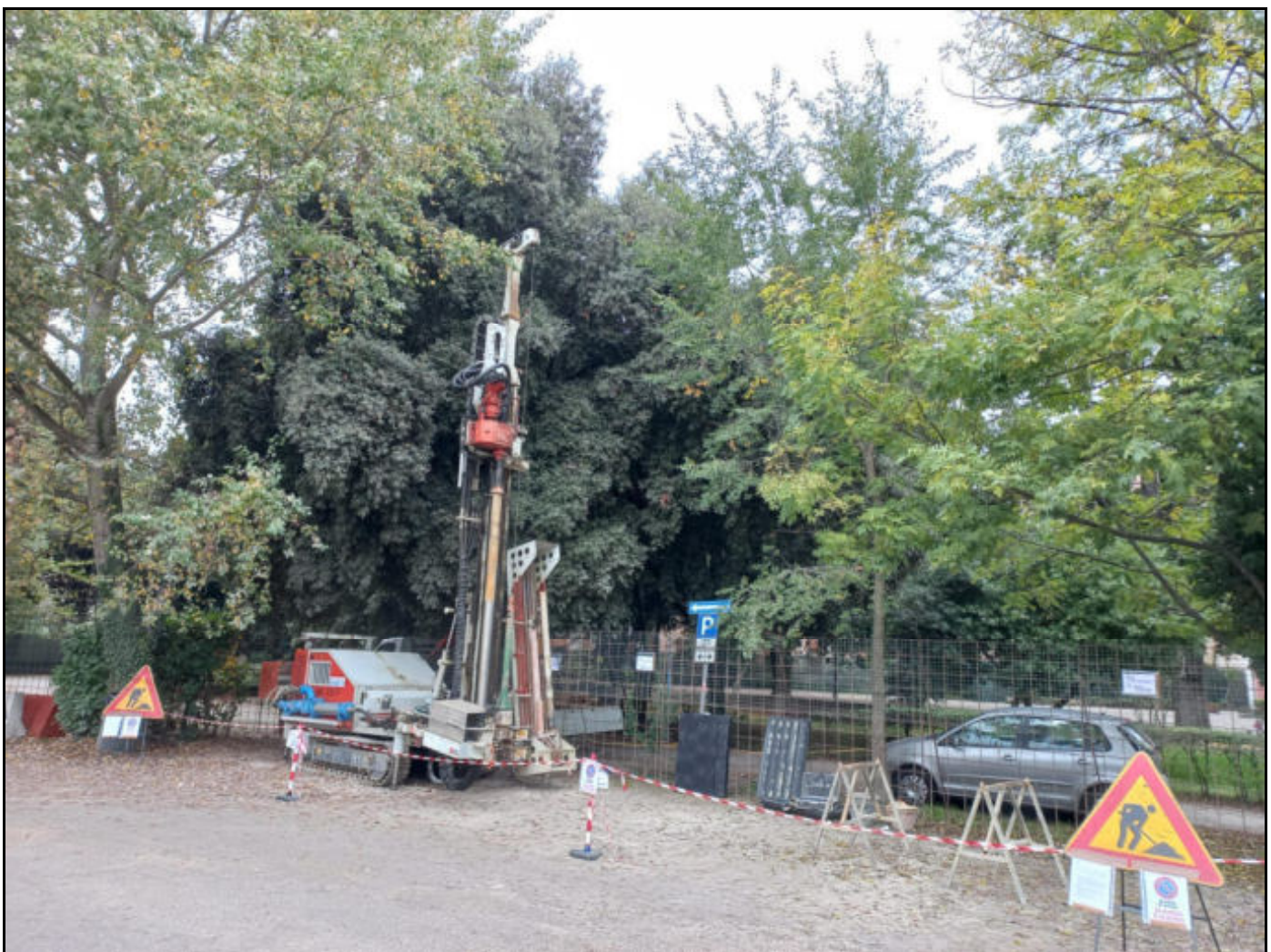
Posizionamento Sondaggio Geognostico S11
