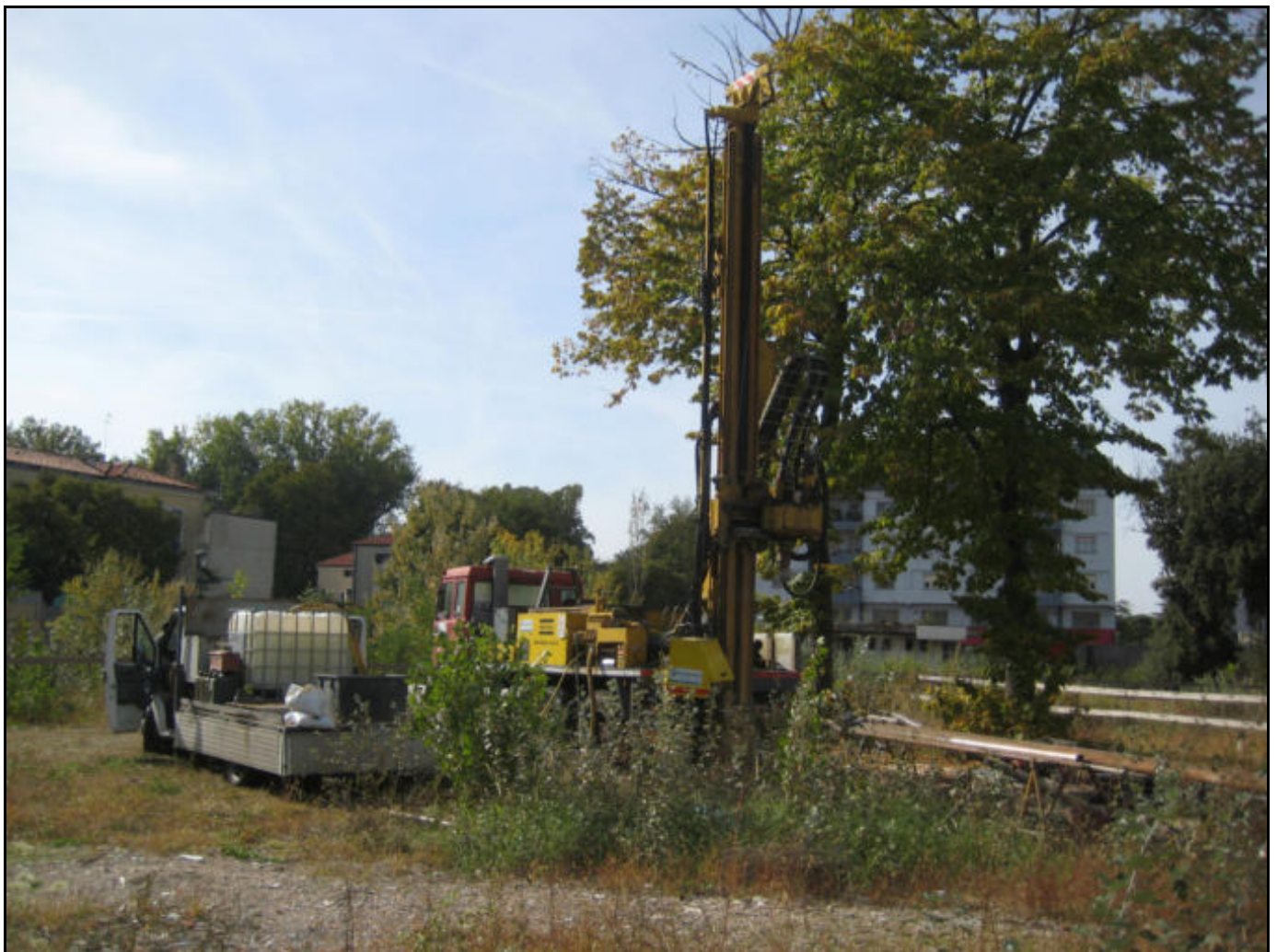
Posizionamento Sondaggio Geognostico S9
