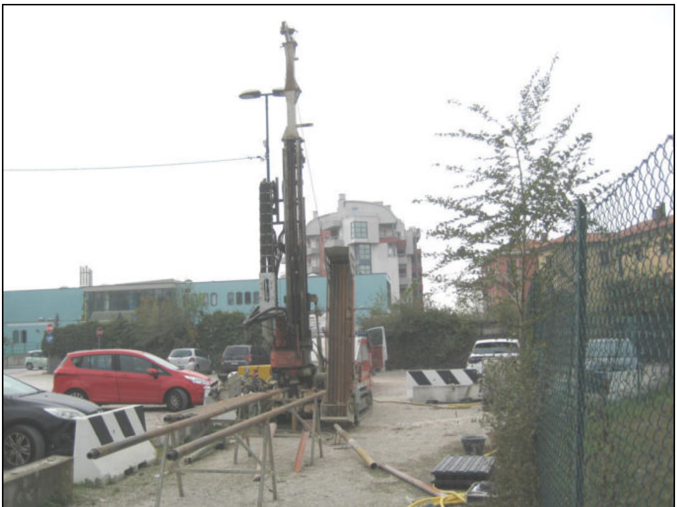
Posizionamento Sondaggio Geognostico S1
