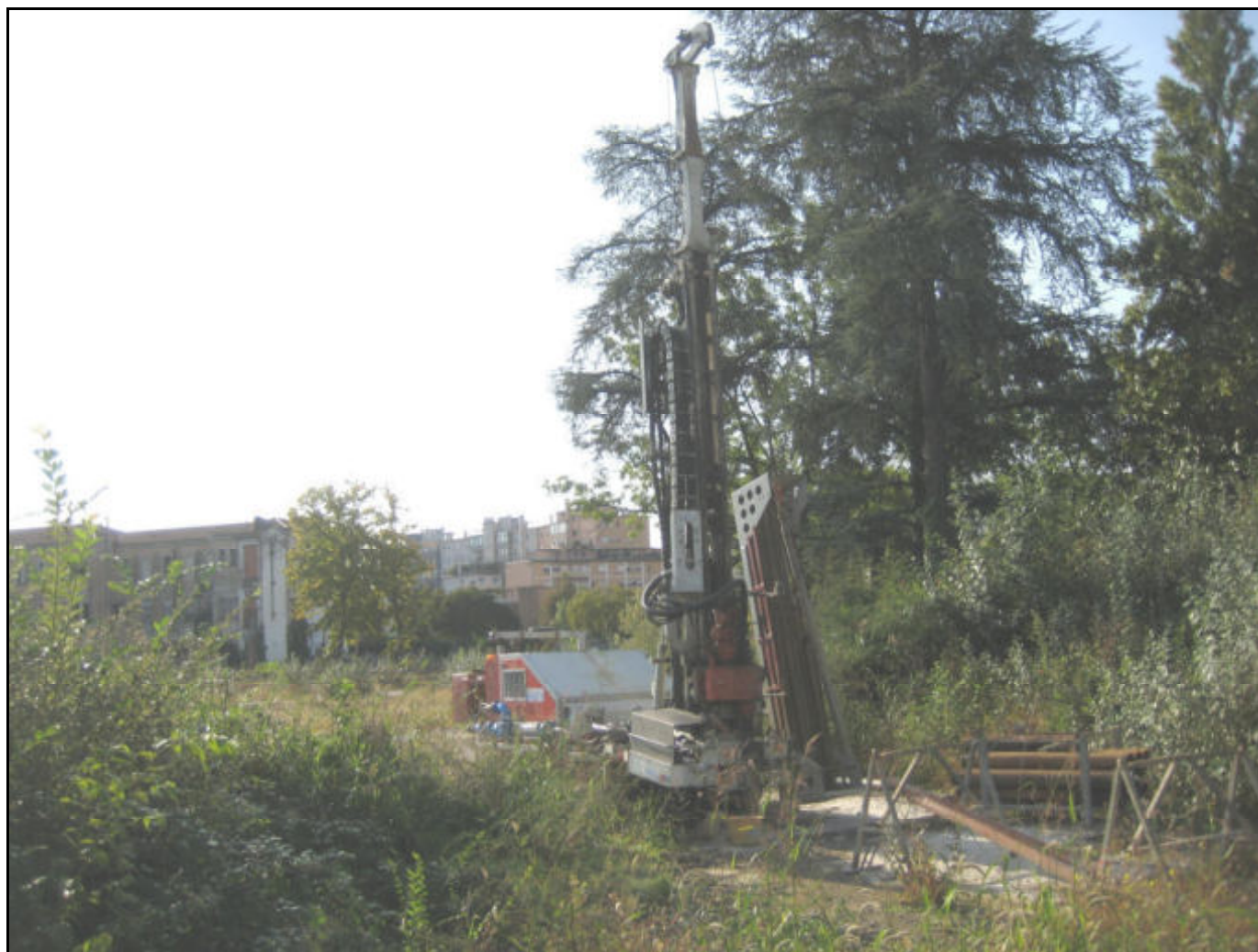
Posizionamento Sondaggio Geognostico S6
