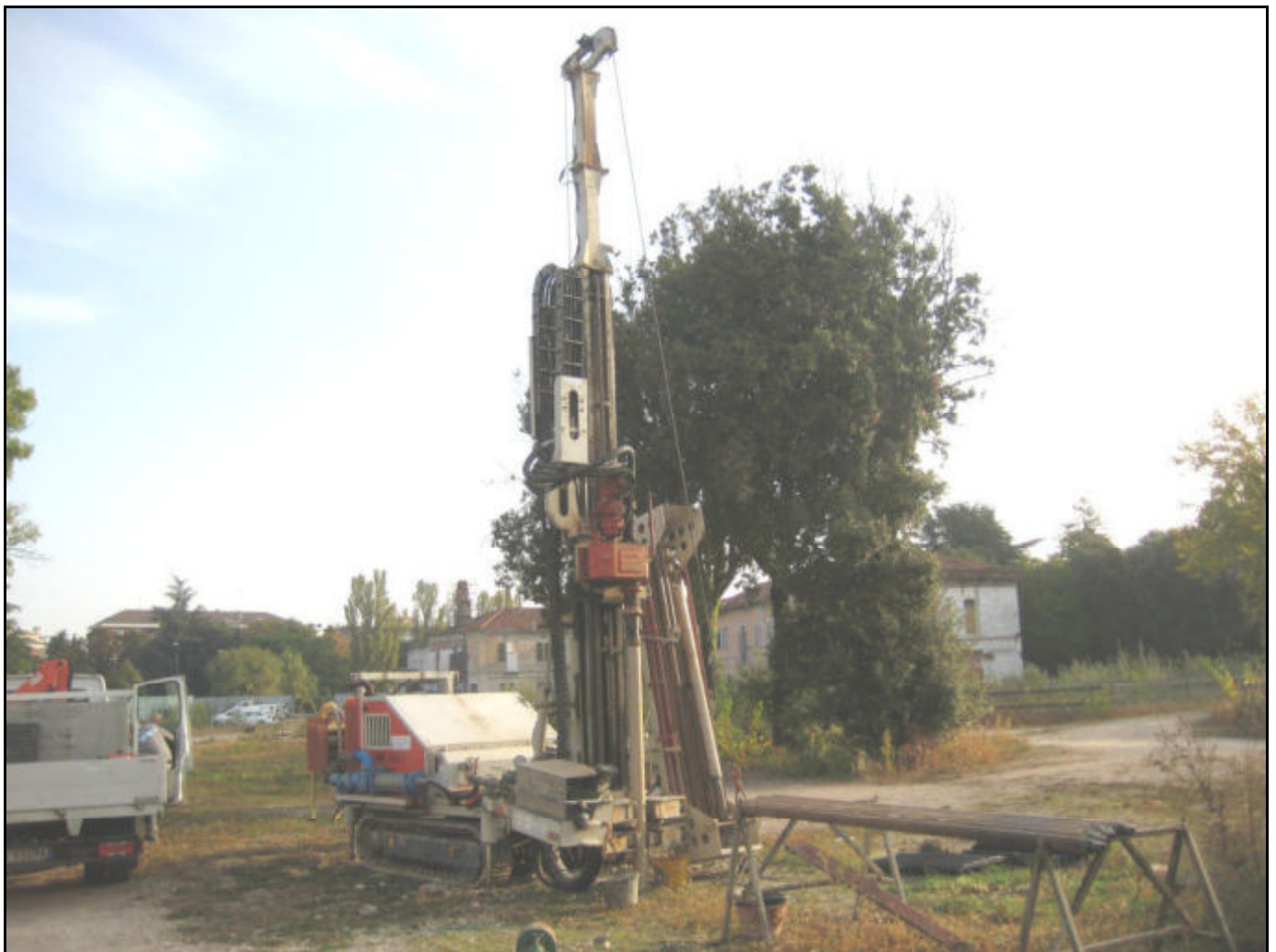
Posizionamento Sondaggio Geognostico S8
