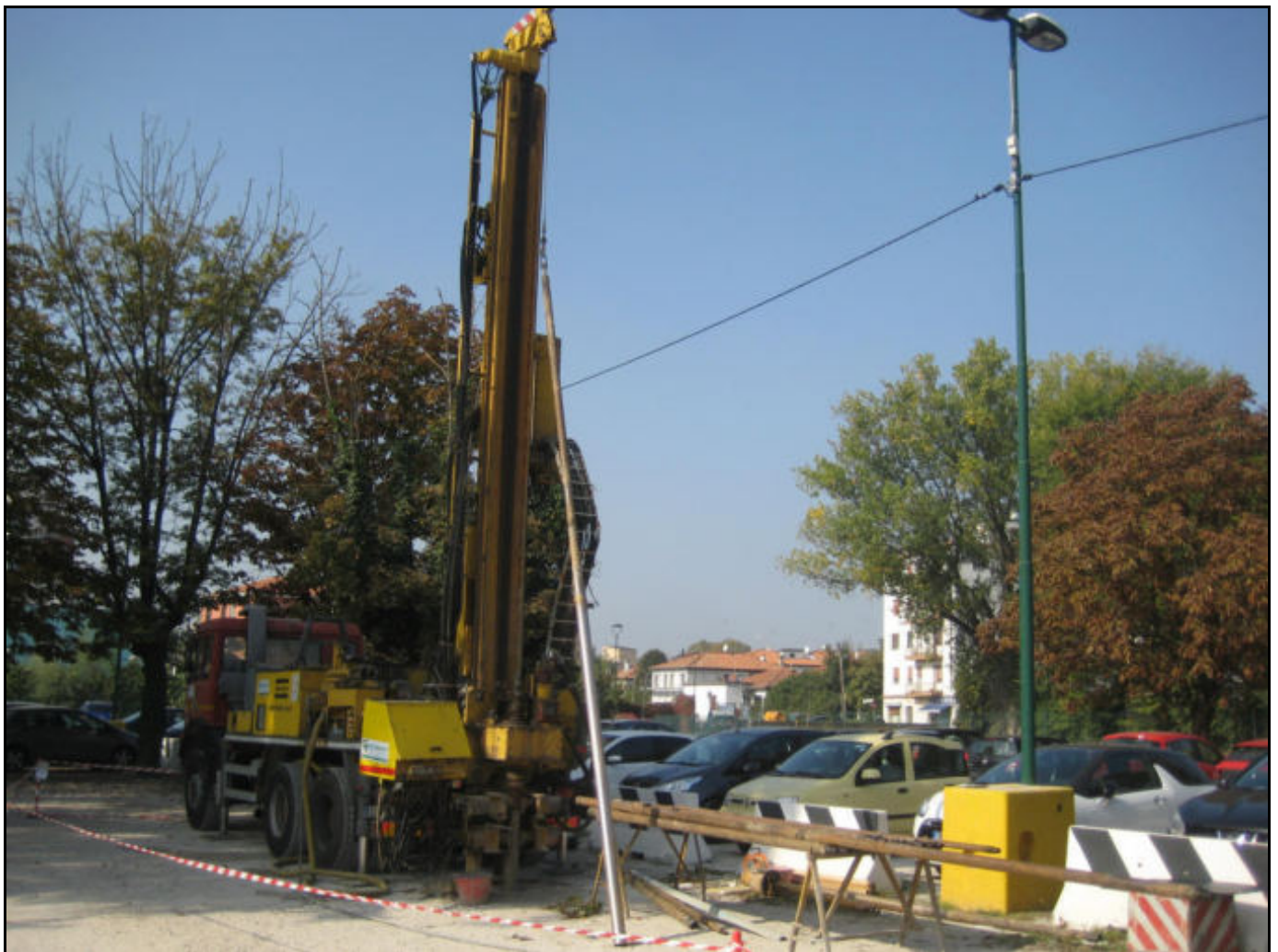
Posizionamento Sondaggio Geognostico S4
