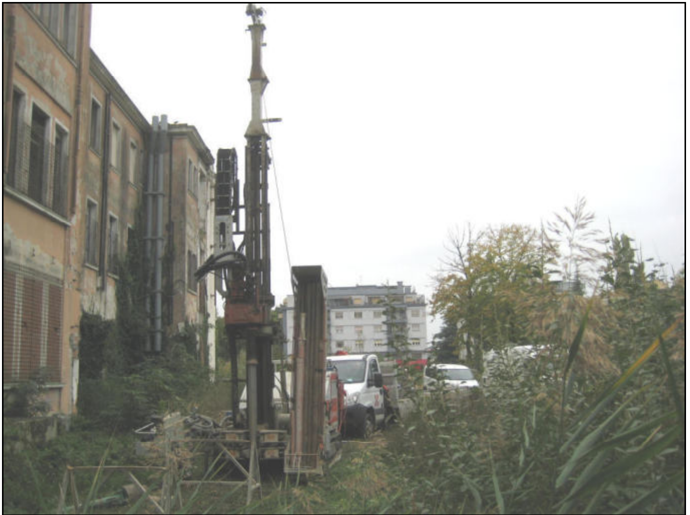
Posizionamento Sondaggio Geognostico S10
