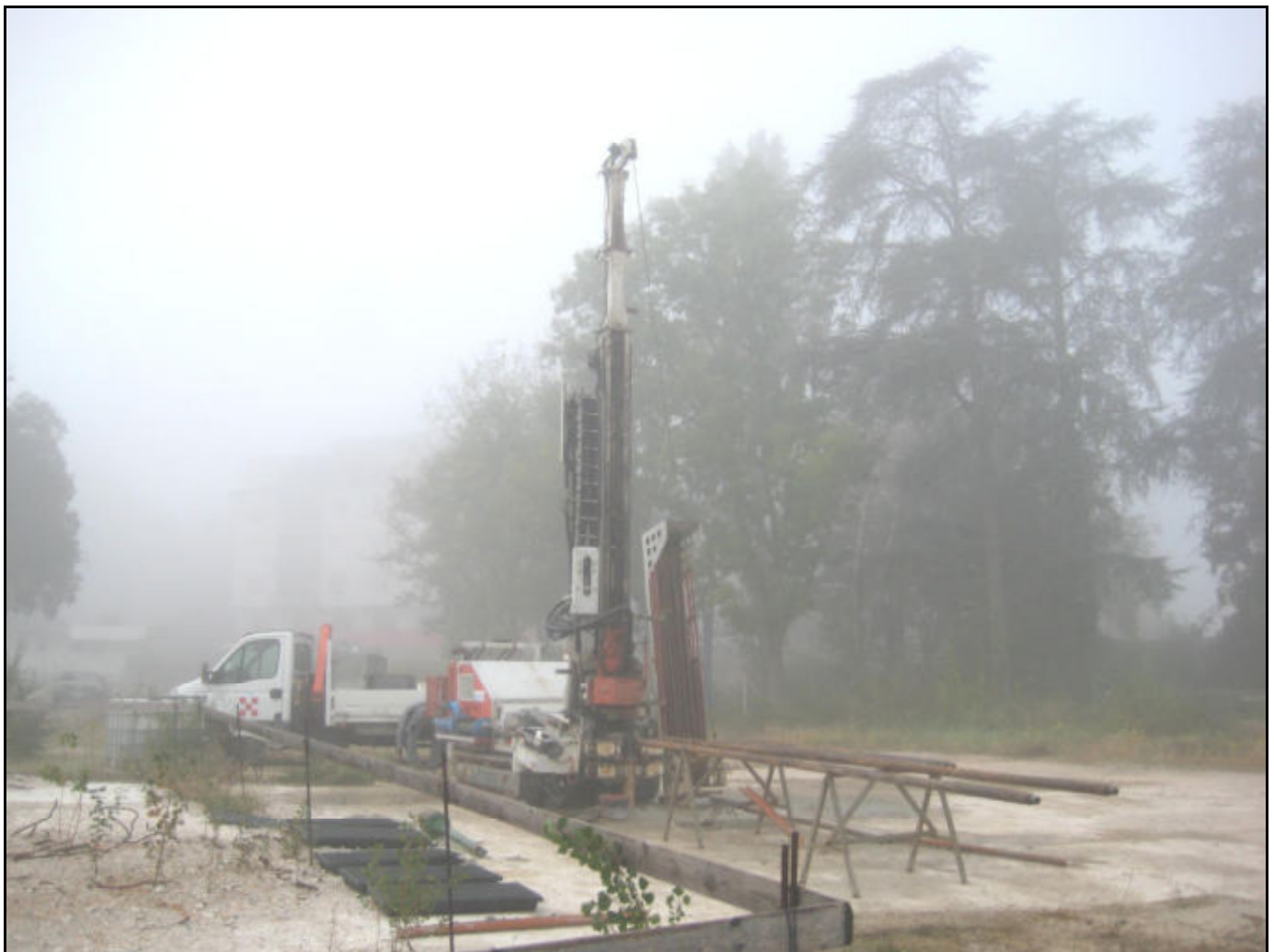
Posizionamento Sondaggio Geognostico S7
