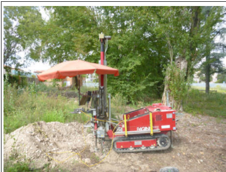
Foto 4: Esecuzione della prova CPTU5
