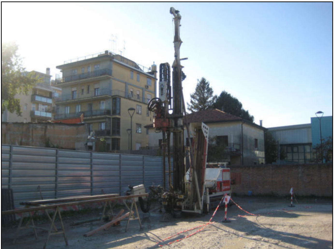
Posizionamento Sondaggio Geognostico S5
