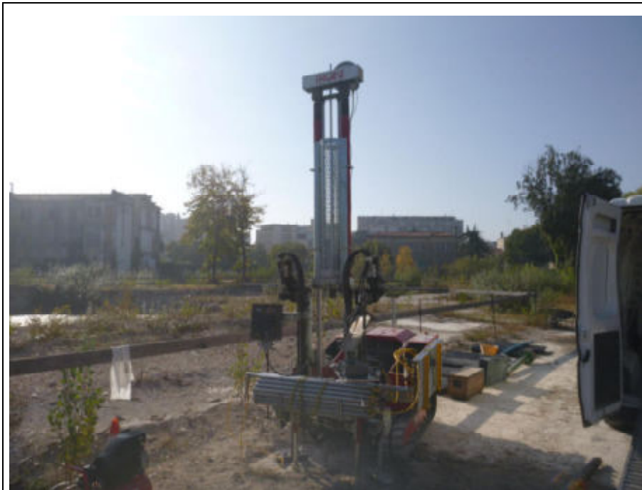
Foto 9: Esecuzione della prova CPTU10
