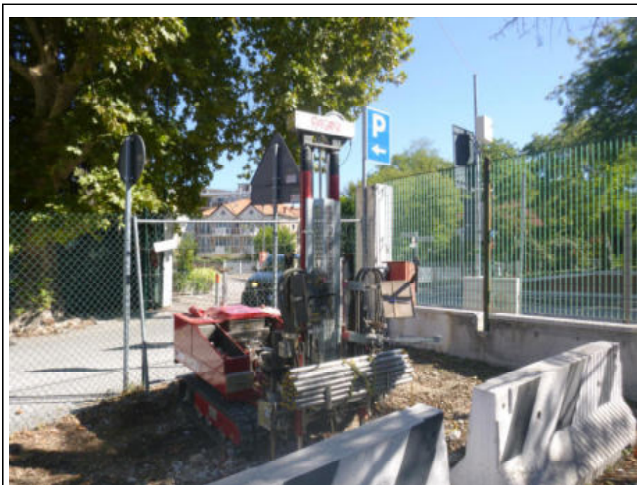
Foto 6: Esecuzione della prova CPTU7
