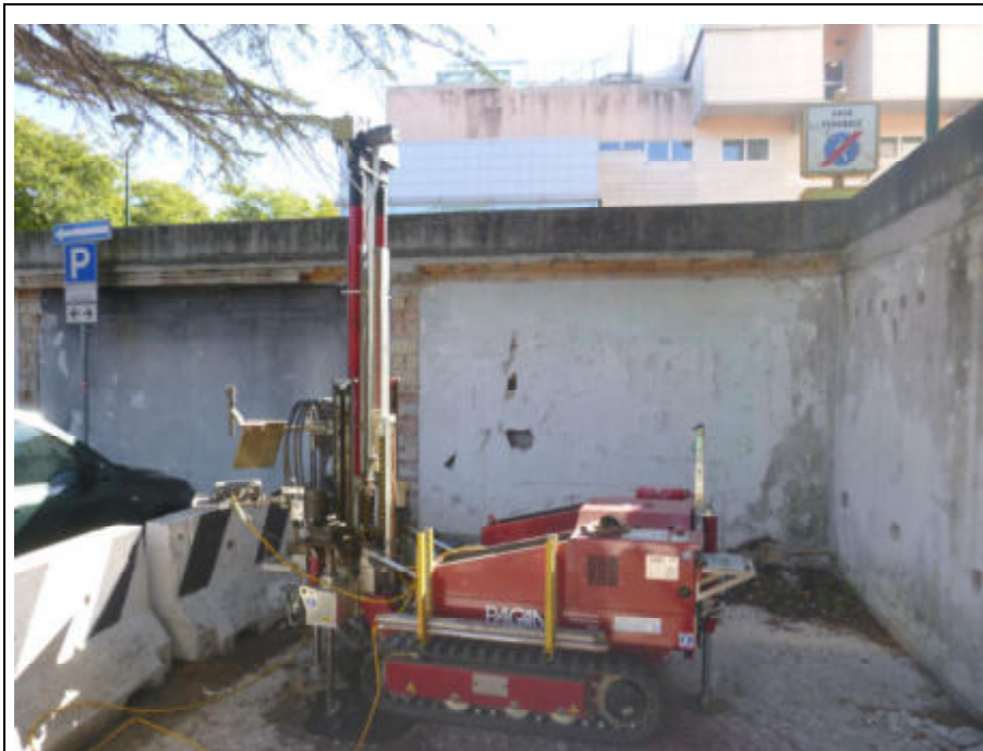
Foto 5: Esecuzione della prova CPTU6
