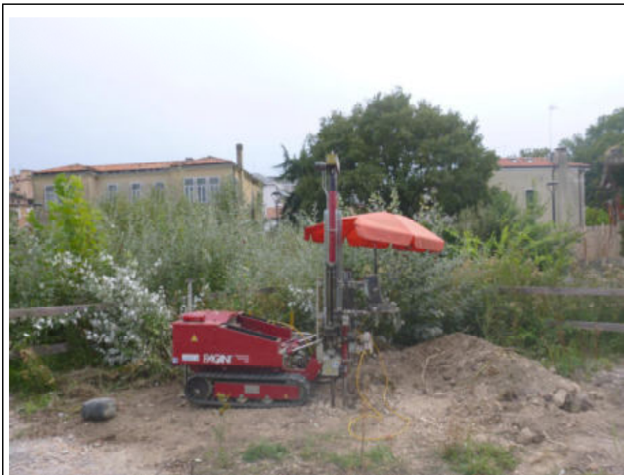
Foto 2: Esecuzione della prova CPTU2
