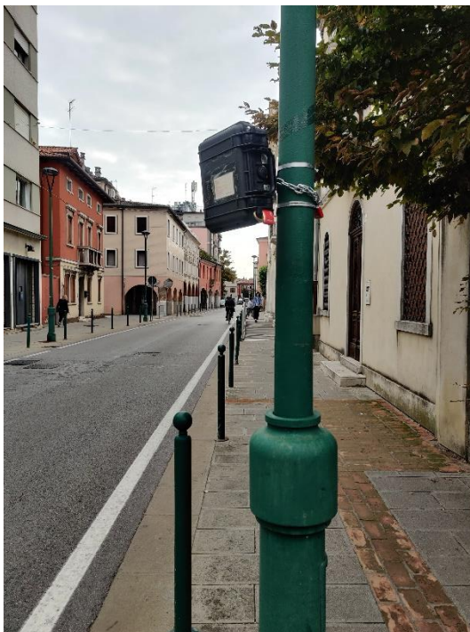
Figura 25: Dispositivo radar installato - via Belfredo
