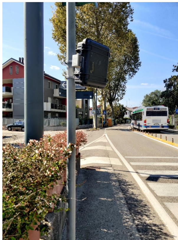
Figura 14: Dispositivo radar installato - via Castellana
