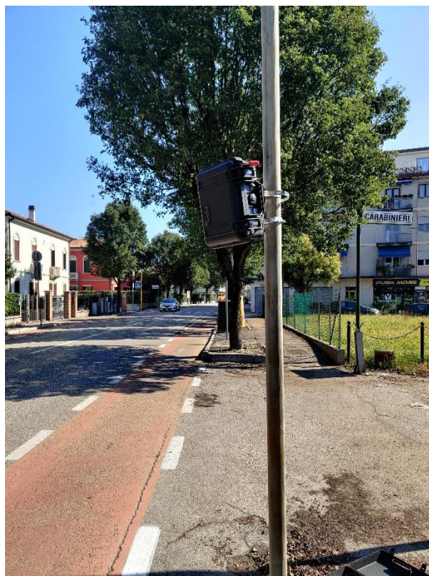
Figura 8: Dispositivo radar installato - via Miranese
