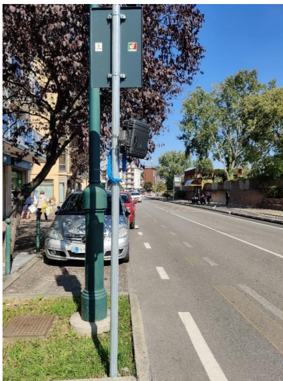
Figura 11: Dispositivo radar installato - via Circonvallazione
