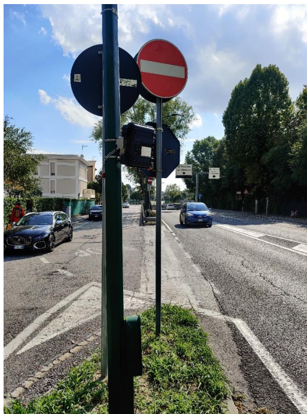
Figura 17: Dispositivo radar installato - via Terraglio
